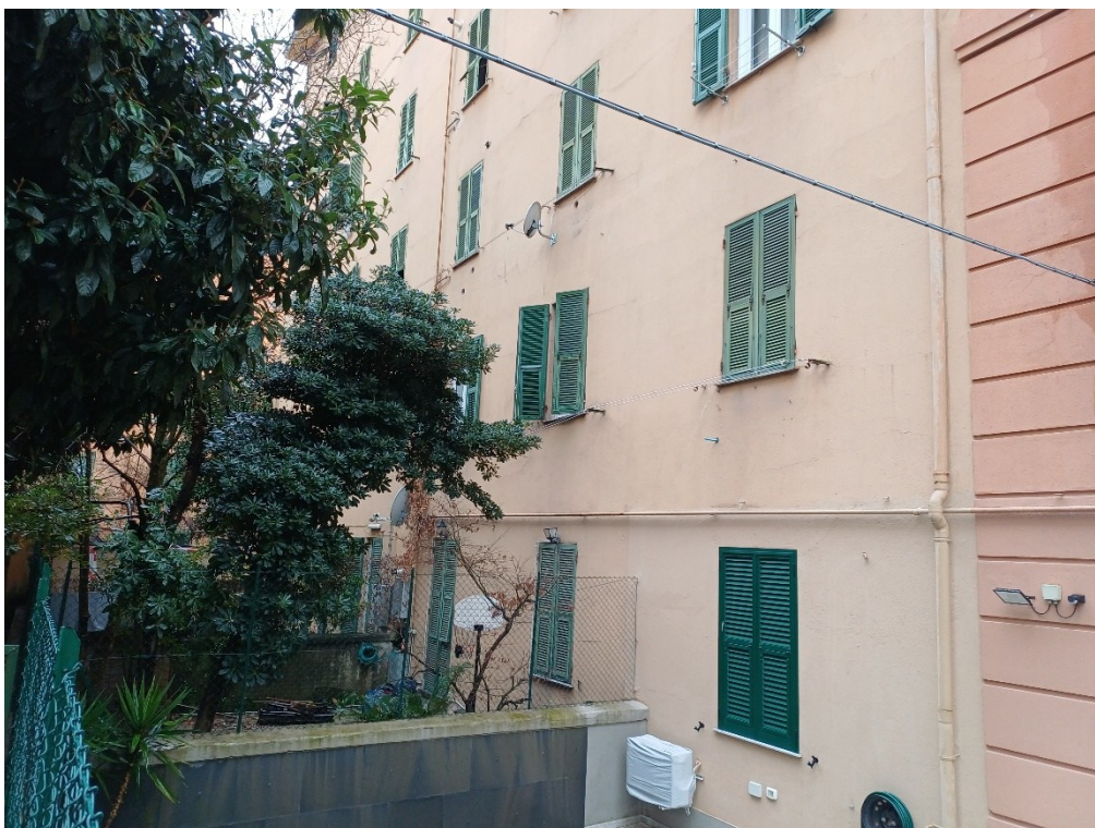
IL PROSPETTO DELL'EDIFICIO VERSO IL FABBRICATO ADIACENTE
