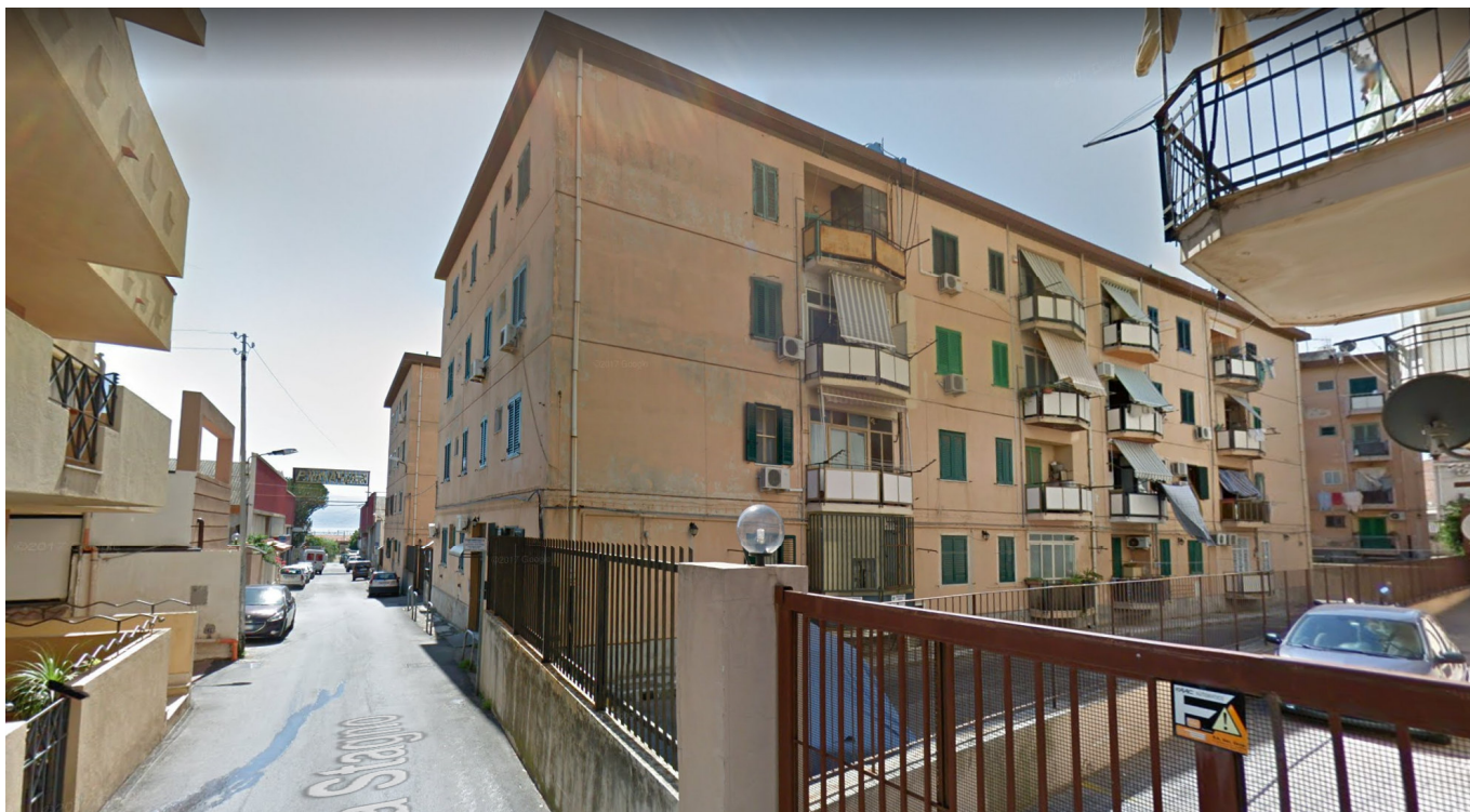
FOTO 1: Accesso alla Palazzina A dalla via Stagno
