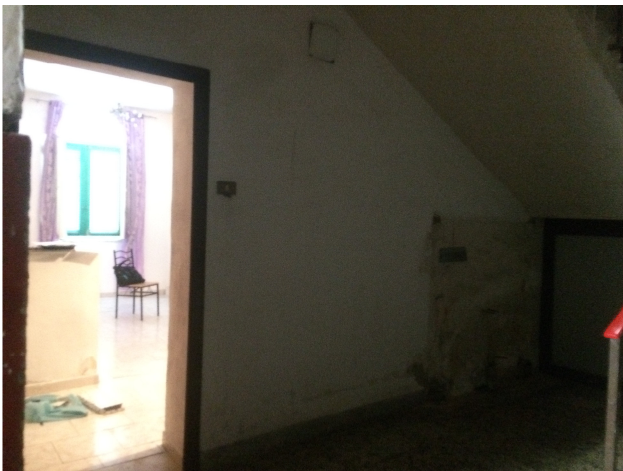
FOTO 6: Pianerottolo e porta di ingresso all'abitazione
