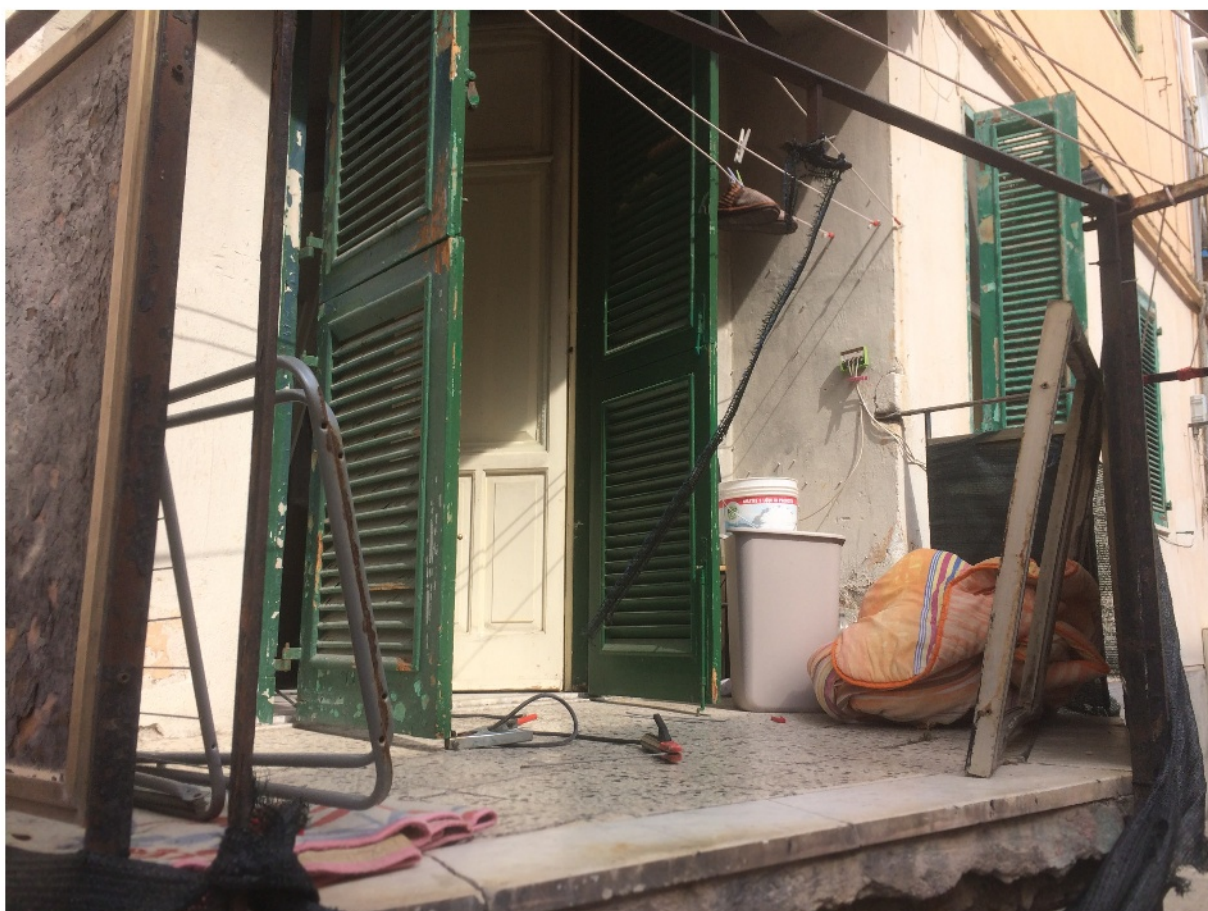
FOTO 21: Balconcino antistante la camera da letto sul prospetto est del fabbricato
