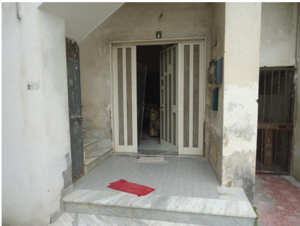
Accesso al locale garage dal cortile comune
