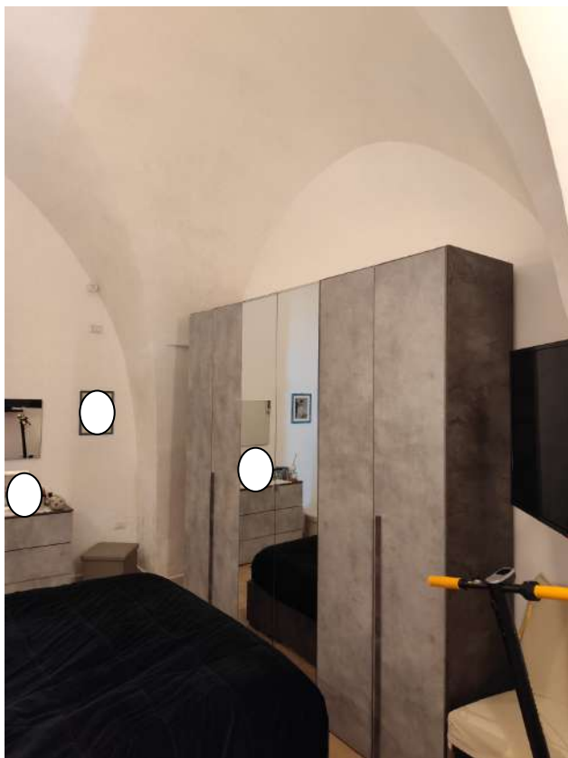
FOTO N. 12 – CAMERA N.2 – PARTICOLARE VOLTA
