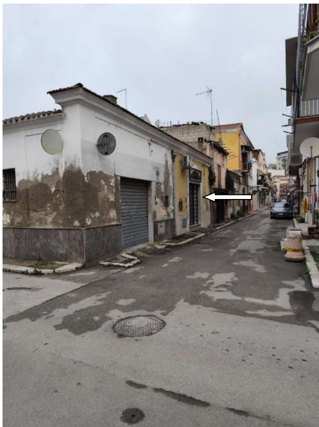
FOTO N. 1 – VISTA PROSPETTICA DI VIA DELL’UVA
