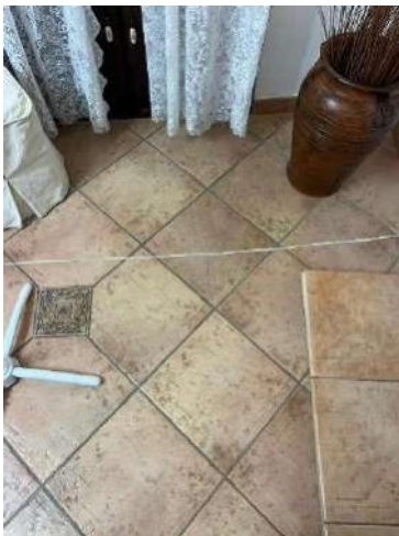
Foto n° 13 lesioni pavimento
