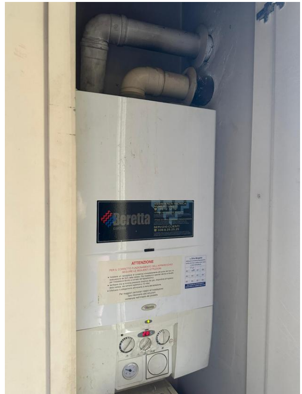
Foto17: Caldaia PS1.
