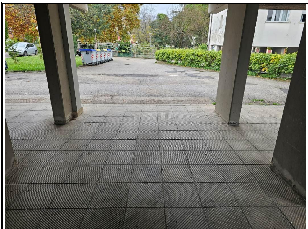
Foto n. 3 Vista del posto auto coperto.
