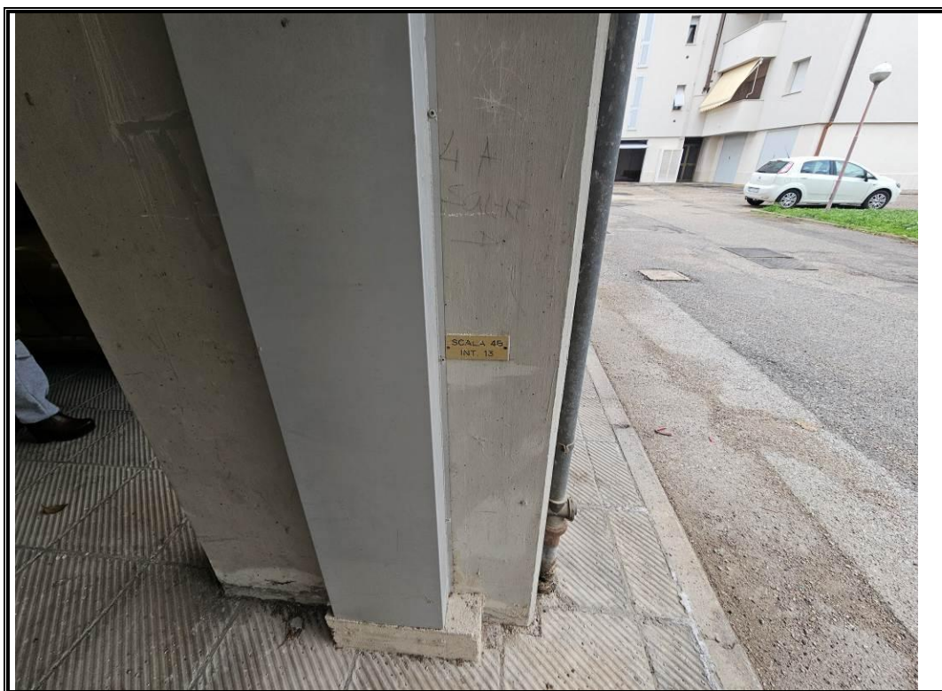
Foto n. 4 Vista del posto auto coperto.
