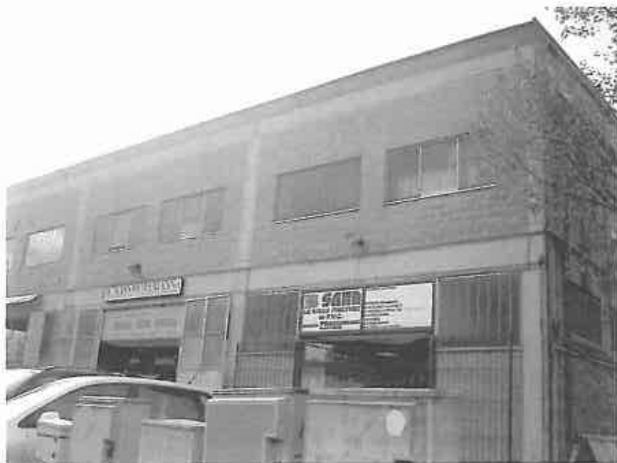
Foto 1 – VISTA PROSPETTO NORD
