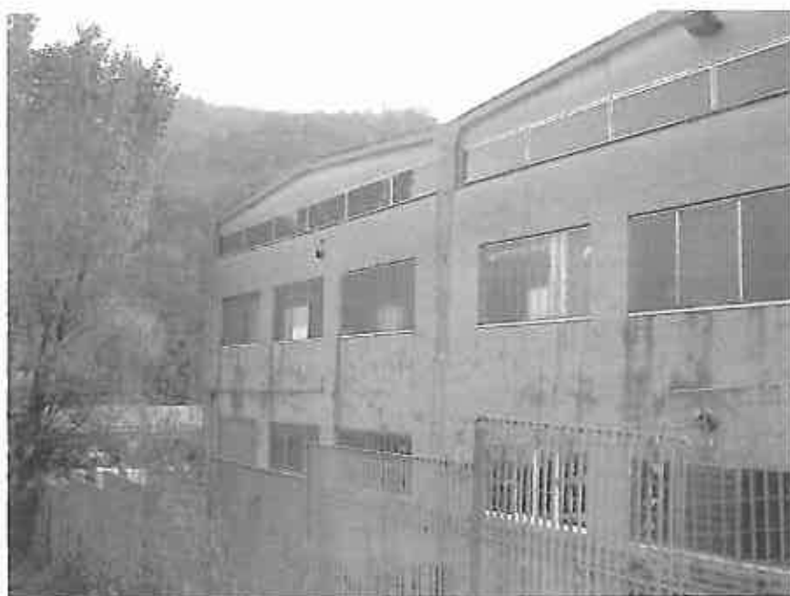
Foto 2 - VISTA PROSPETTO OVEST
