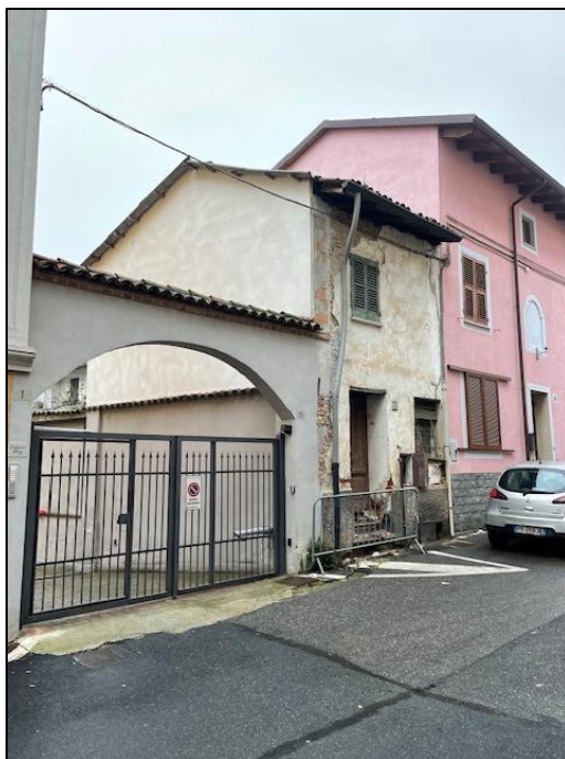
Vista interna da Via Asilo Raggio
