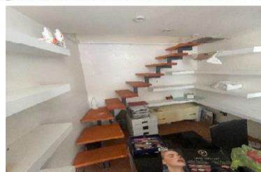
Figura 24: Vista scala accesso soppalco
