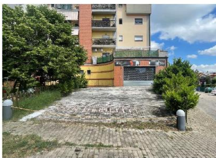
Figura 5: Vista fabbricato da Via Isabella Morra
