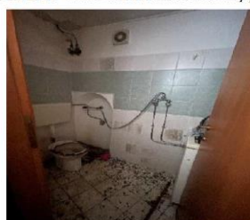
Figura 26: Vista del WC
