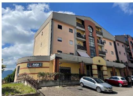
Figura 4: Vista fabbricato da Via Antonio De Curtis
