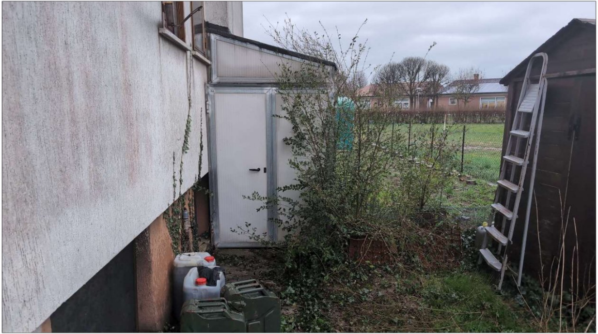
Vista dei due manufatti a Nord: a sinistra locale caldaia, a destra ricovero attrezzi.
