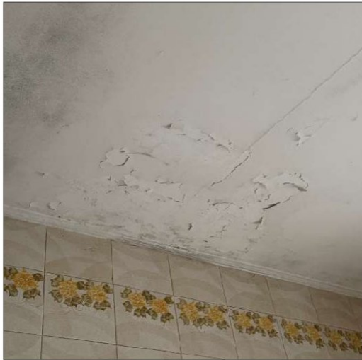
Vista di alcuni dettagli (infiltrazioni/muffa in camera).
