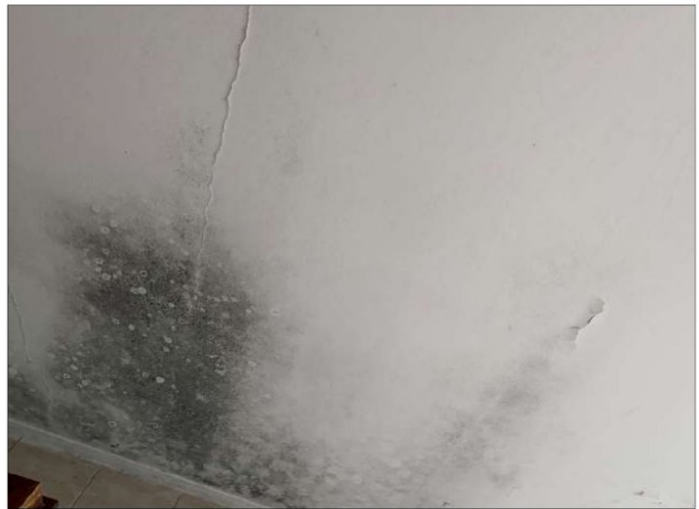
Vista di alcuni dettagli (infiltrazioni/muffa in camera).
