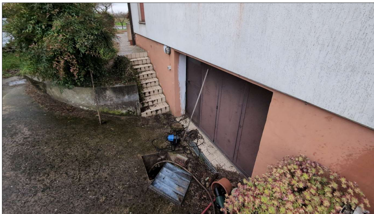
Vista del garage da Nord-Ovest e del pozzetto antistante l'entrata
