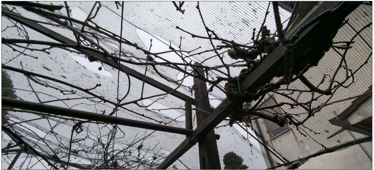
Vista della struttura a gazebo e dettaglio della copertura
