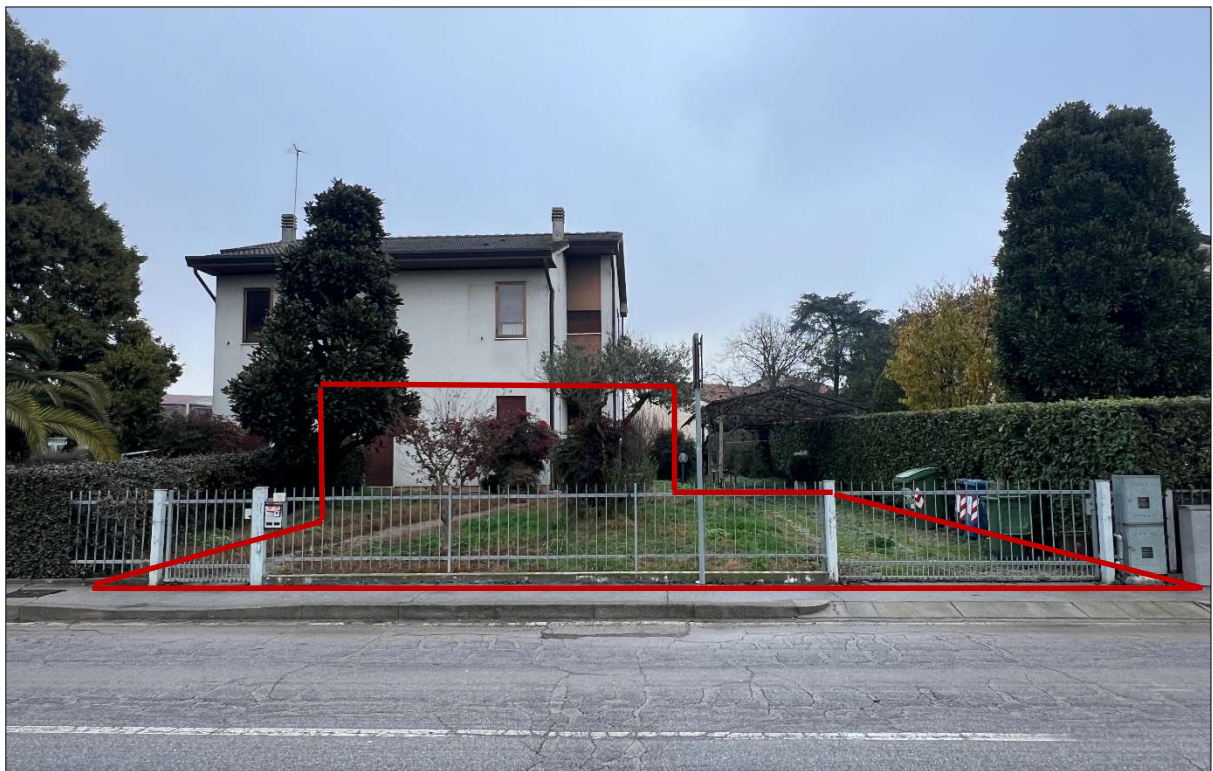
Vista del fabbricato da Sud, via del Municipio. In rosso: individuazione del cespite
