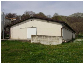
FOTO N. 5 – prospetto sud porcilaia al F. 13 p.lla 1242 e terreno al F. 13 p.lla 1241
