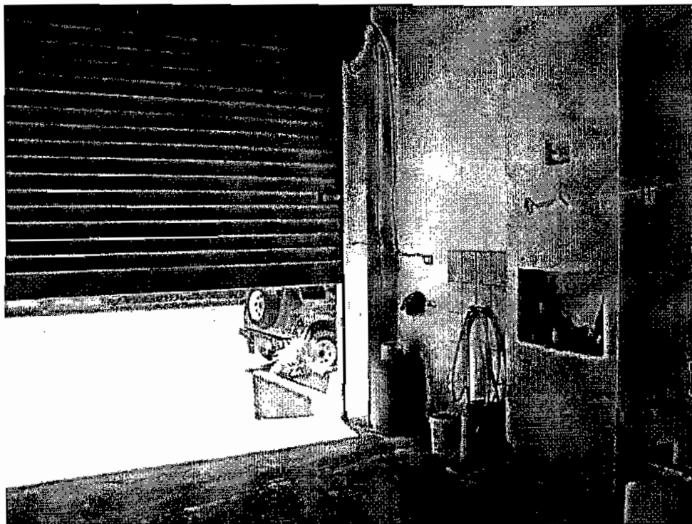
FOTO N. 3 – garage (F. 14 p.la 2259 sub 4 scheda 10/82)
