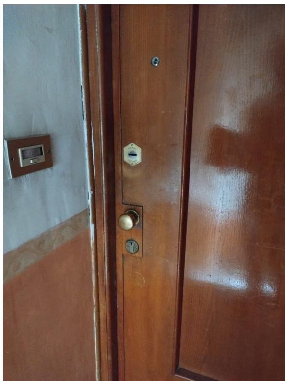
1. Portone accesso appartamento
