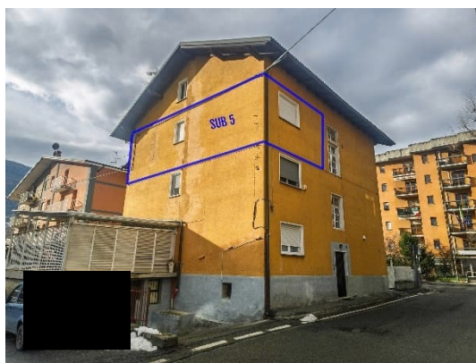
Foto 1 - Vista nord-est edificio
