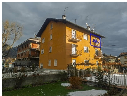
Foto 2 - Vista sud-ovest edificio
