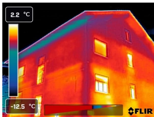
Foto 20 – Termografia nord-ovest edificio
