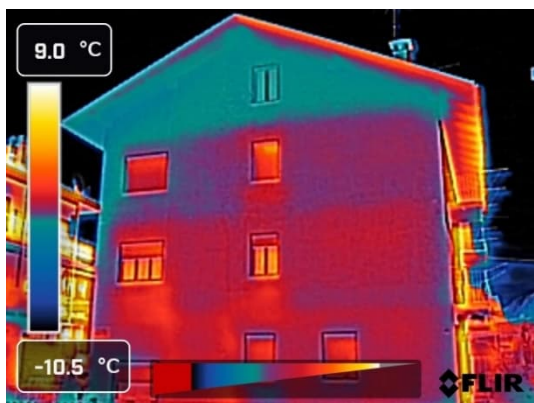
Foto 19 – Termografia ovest edificio
