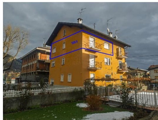
Foto 2 - Vista sud-ovest edificio
