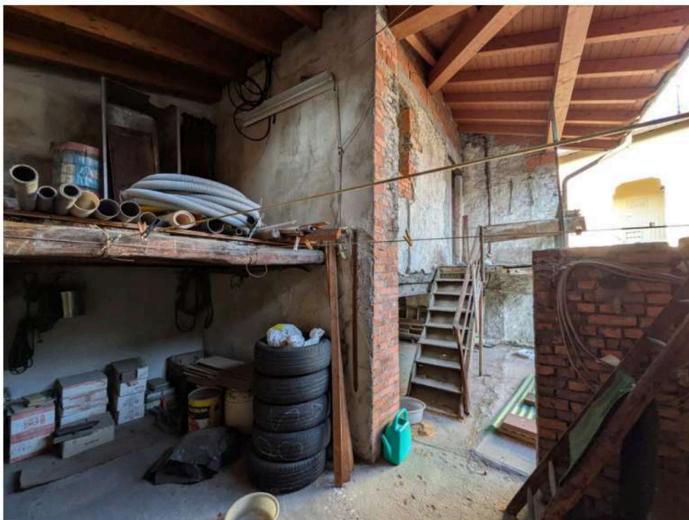
Foto 21 – ambienti in copertura al rustico Lotto 2
