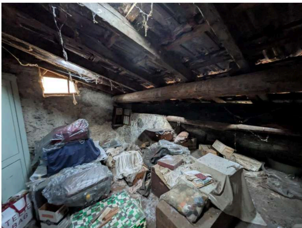
Foto 18 – sottotetto a sgombero Lotto 2
