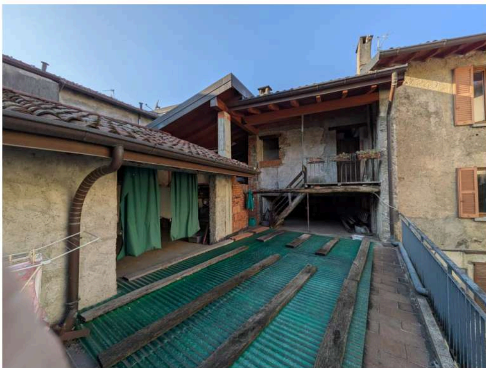
Foto 19 – terrazza interna Lotto 2
