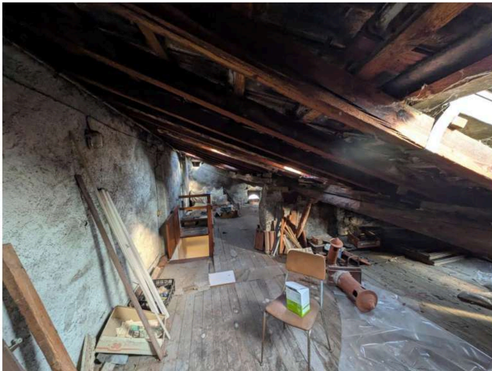
Foto 17 – sottotetto a sgombero Lotto 2
