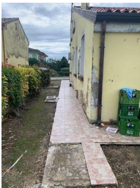
Marciapiede di accesso
