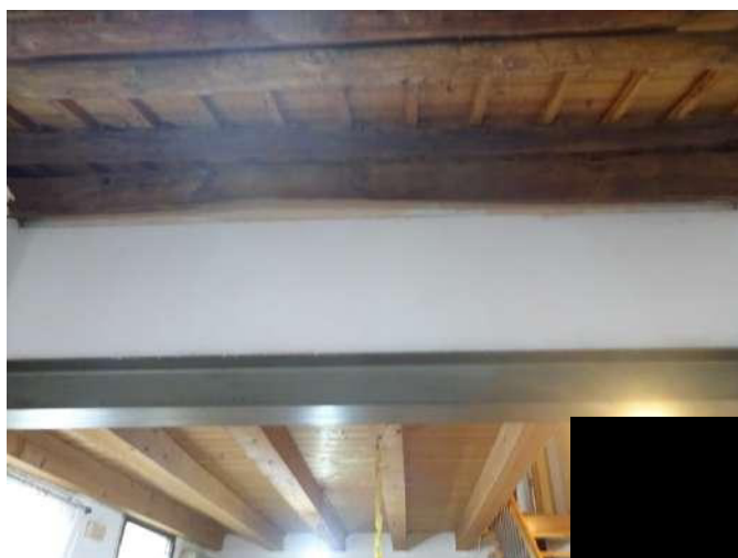
Particolare soffitti soggiorno
