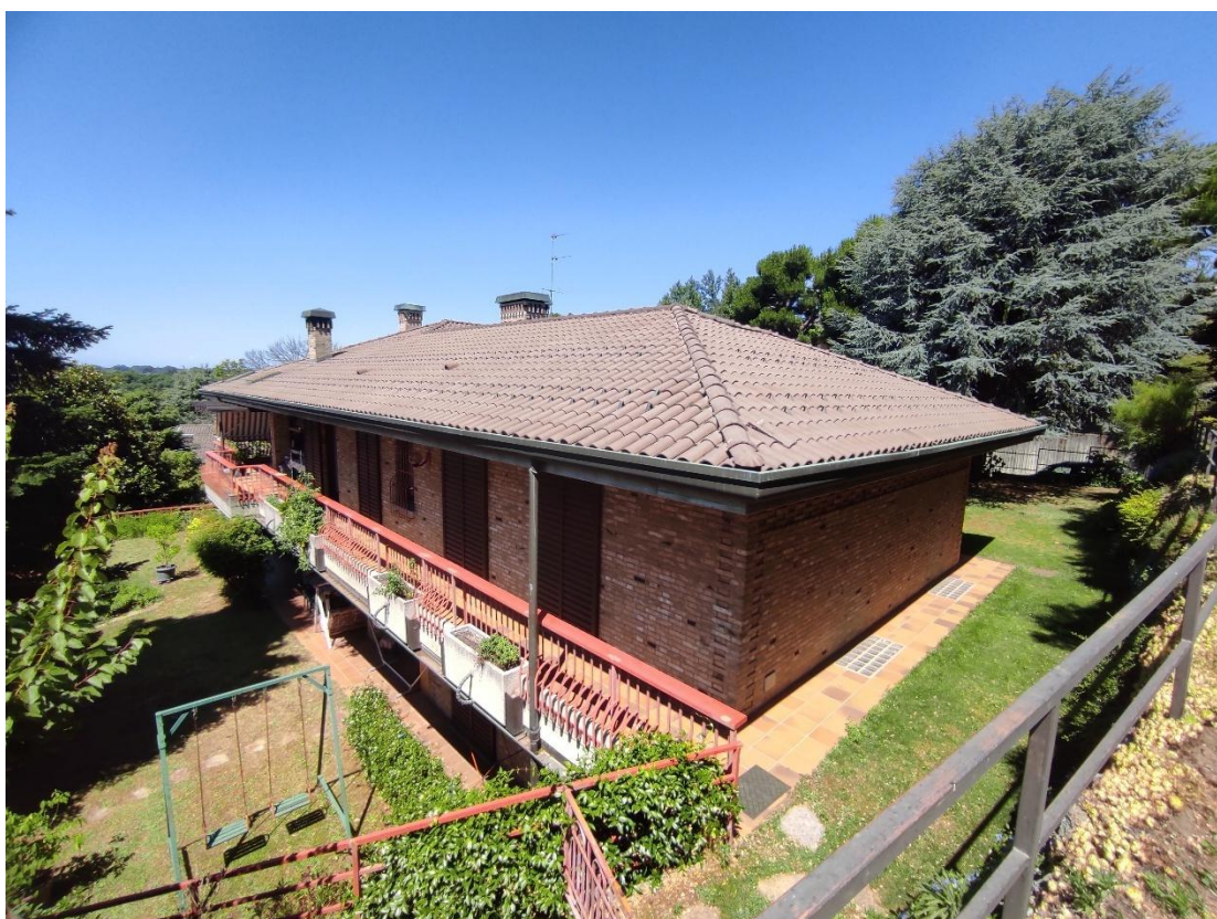
6. Vista fronte est e sud del fabbricato, balcone ed area esterna di pertinenza dell' appartamento al piano primo
