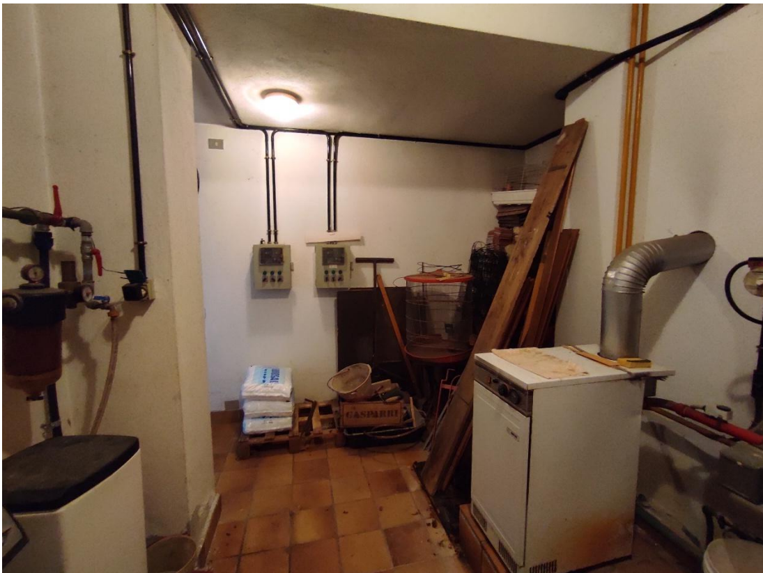
20. Vista locale comune al piano primo sottostrada (part. 50 sub. 701)
