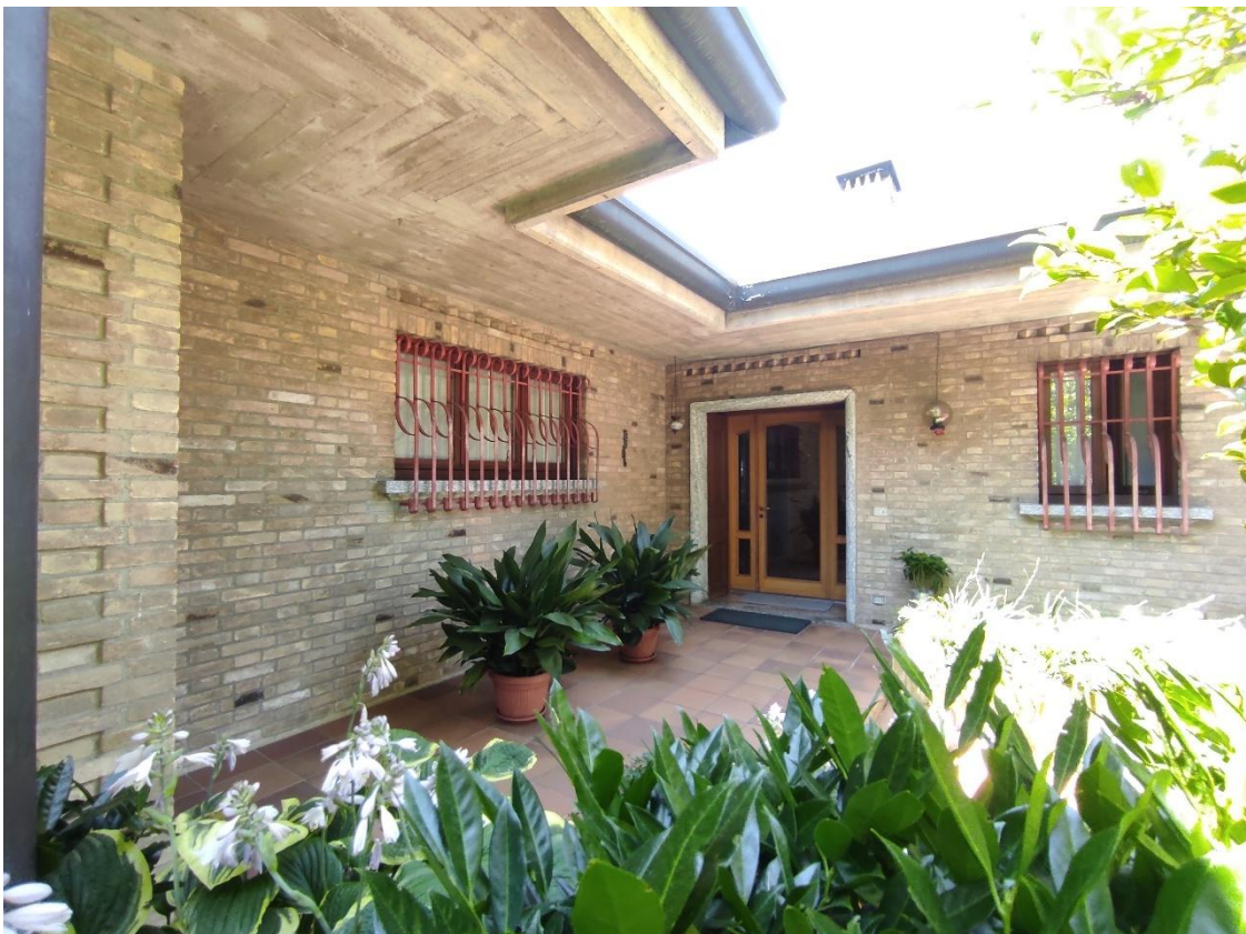
4. Vista ingresso appartamento al piano primo dall'area esterna di pertinenza
