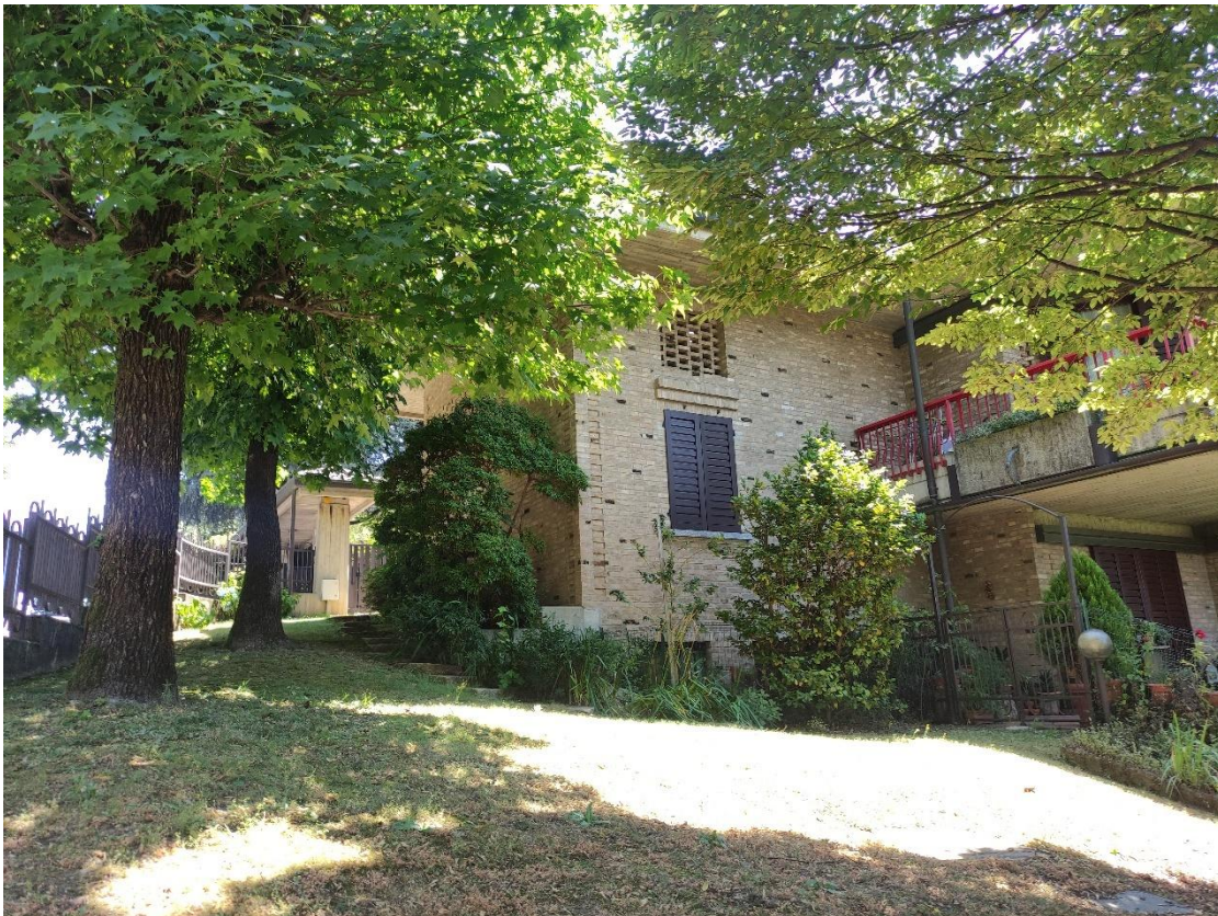
8. Vista facciata nord ed ovest del fabbricato ed area esterna di pertinenza dell'appartamento al piano primo
