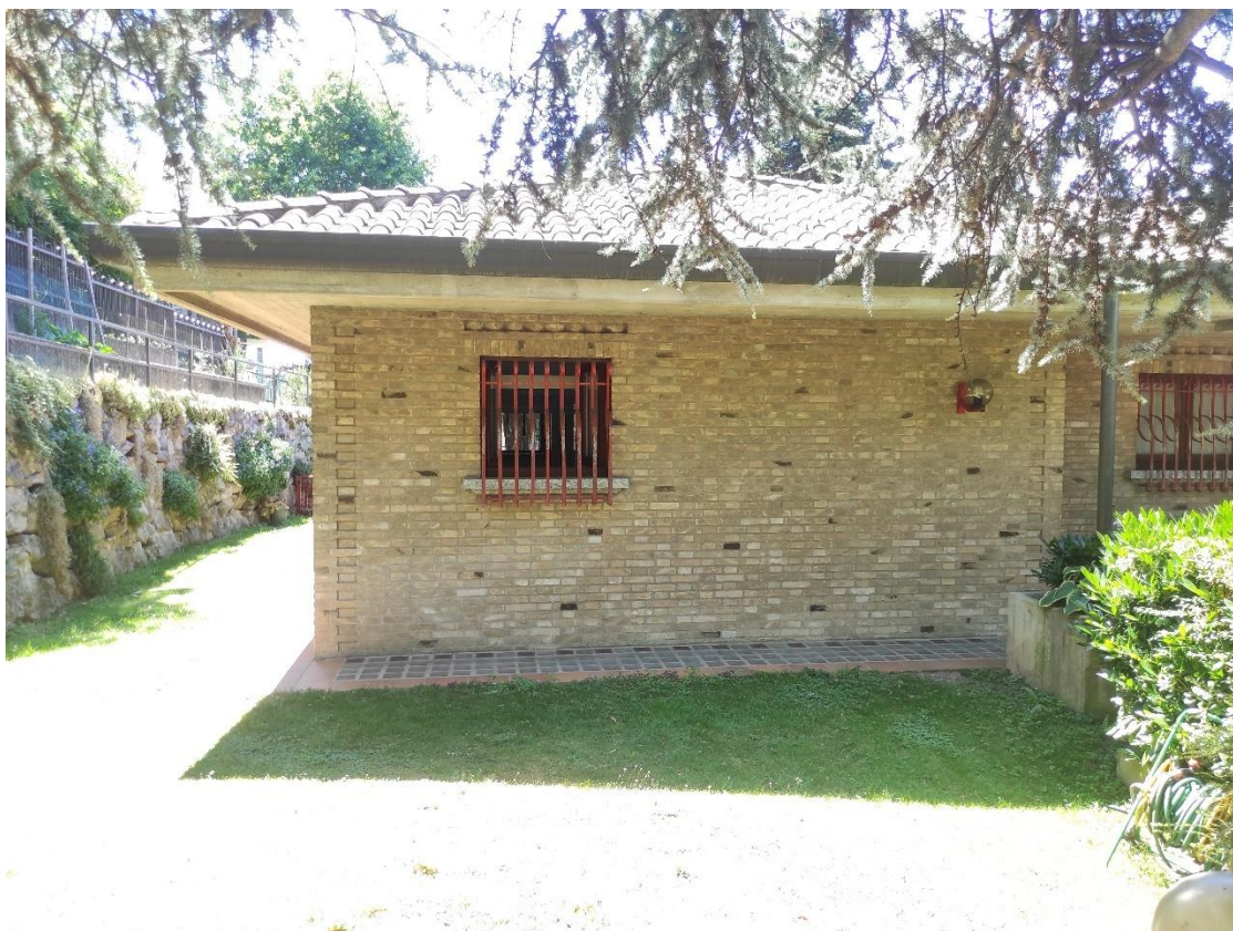
5. Vista fronte nord del fabbricato ed area esterna di pertinenza dell' appartamento al piano primo
