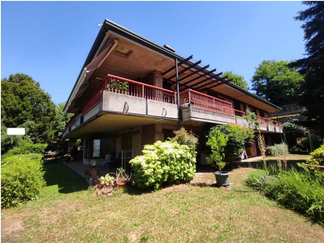
7. Vista facciata ovest e sud del fabbricato
