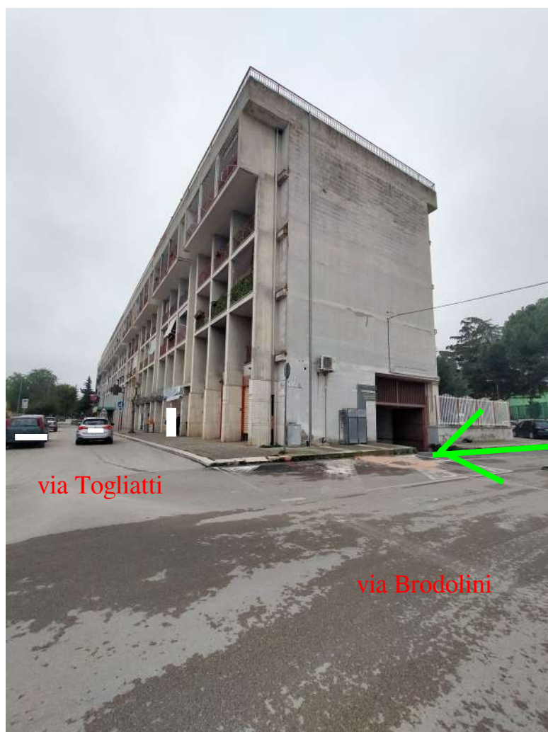
Vista del fabbricato
