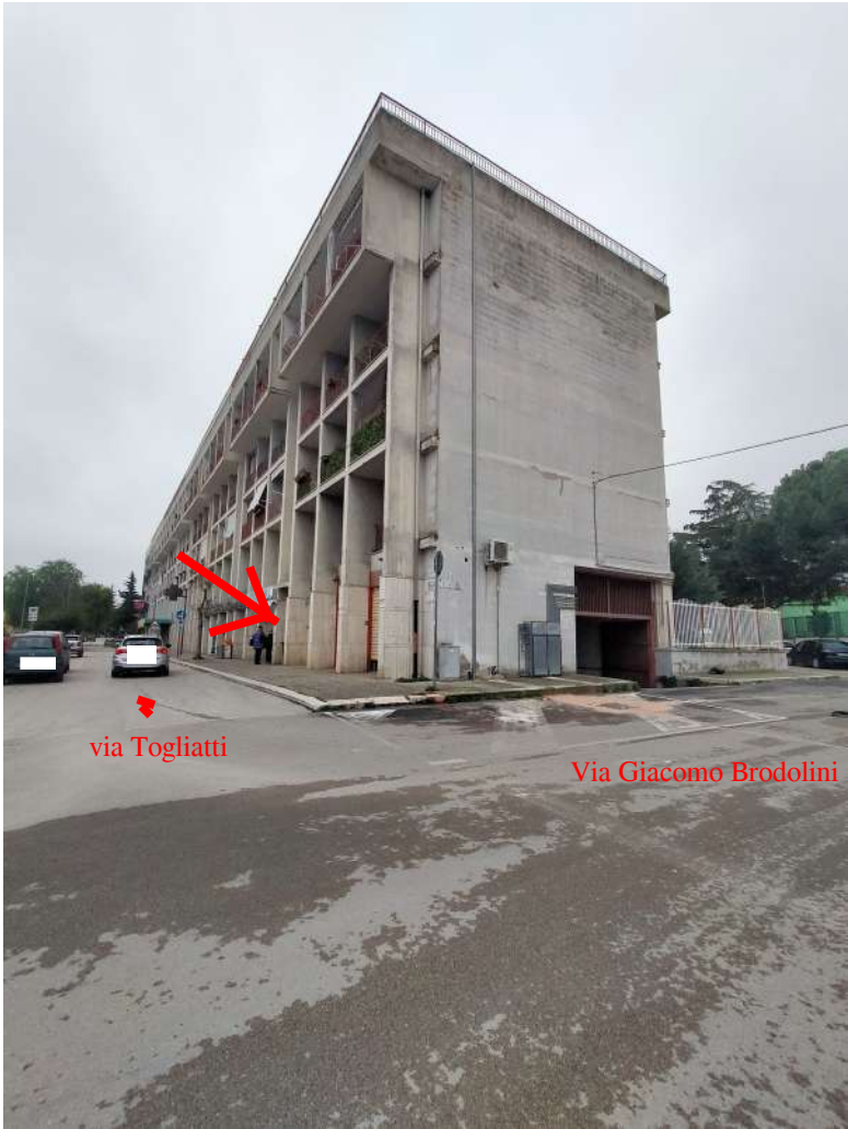
Vista del fabbricato
