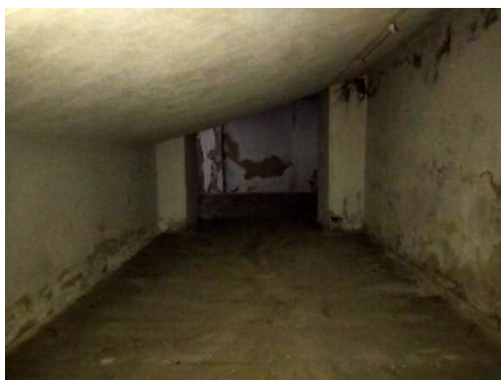
sotto rampa che mette in collegamento i sub 55 e 104 (vista da sub 55)
