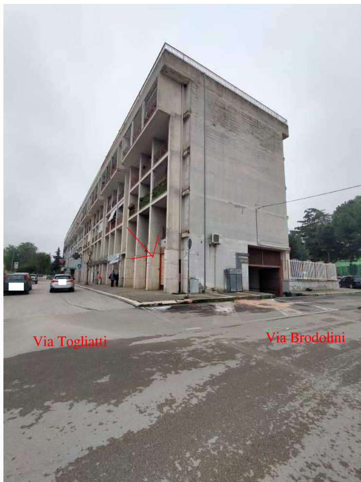
Vista del fabbricato
