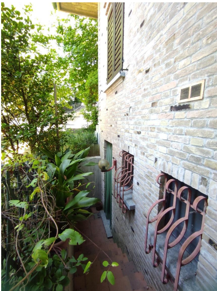
15. Vista esterno della cantina comune (part. 50 sub. 703)
