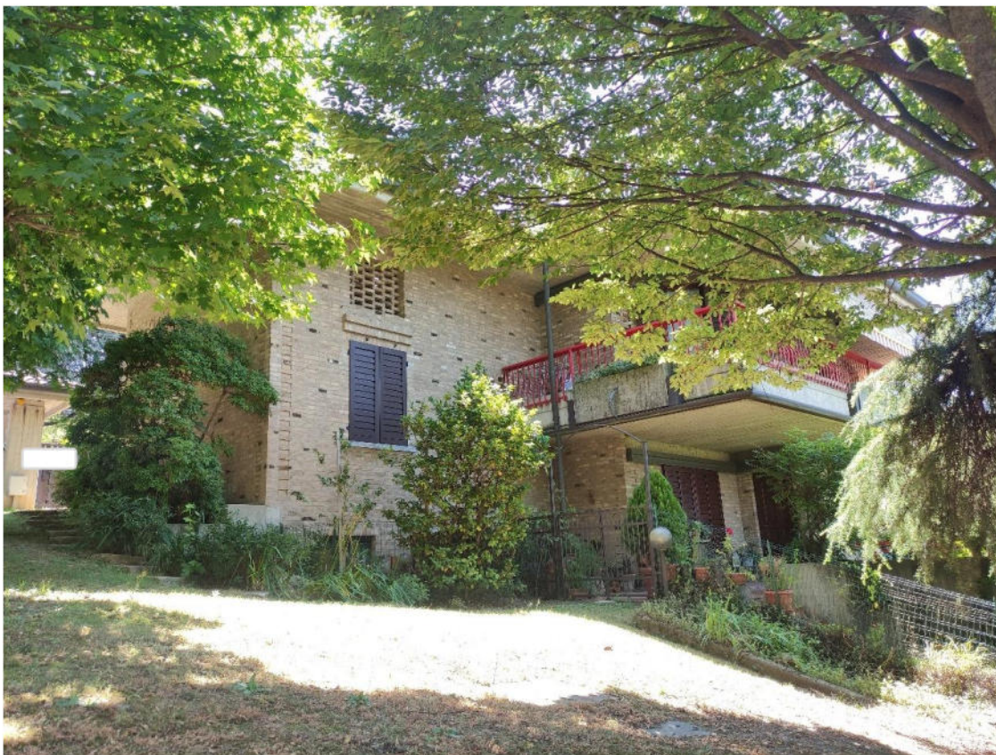
3. Vista facciata ovest
