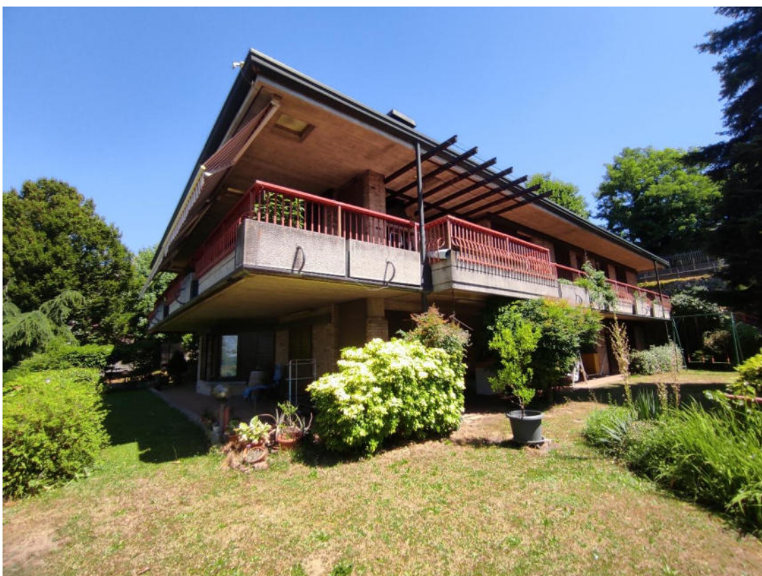
4. Vista facciata ovest e sud ed area di pertinenza appartamento al piano terra
