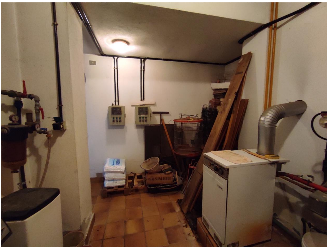
16. Vista locale comune al piano primo sottostrada (part. 50 sub. 701)
