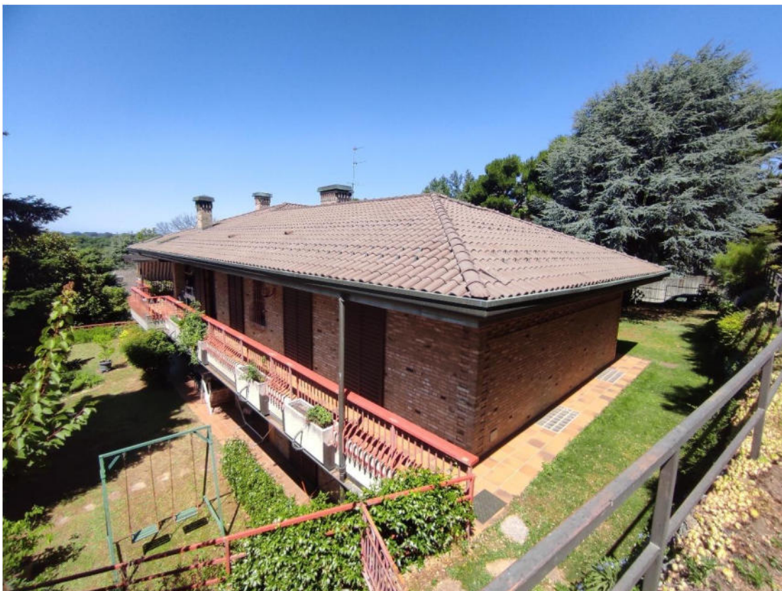
5. Vista copertura fabbricato ed area esterna
