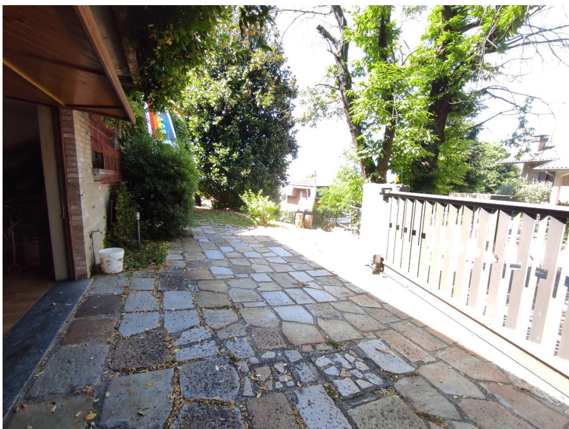
14. Vista area esterna di pertinenza dell'autorimessa comune
