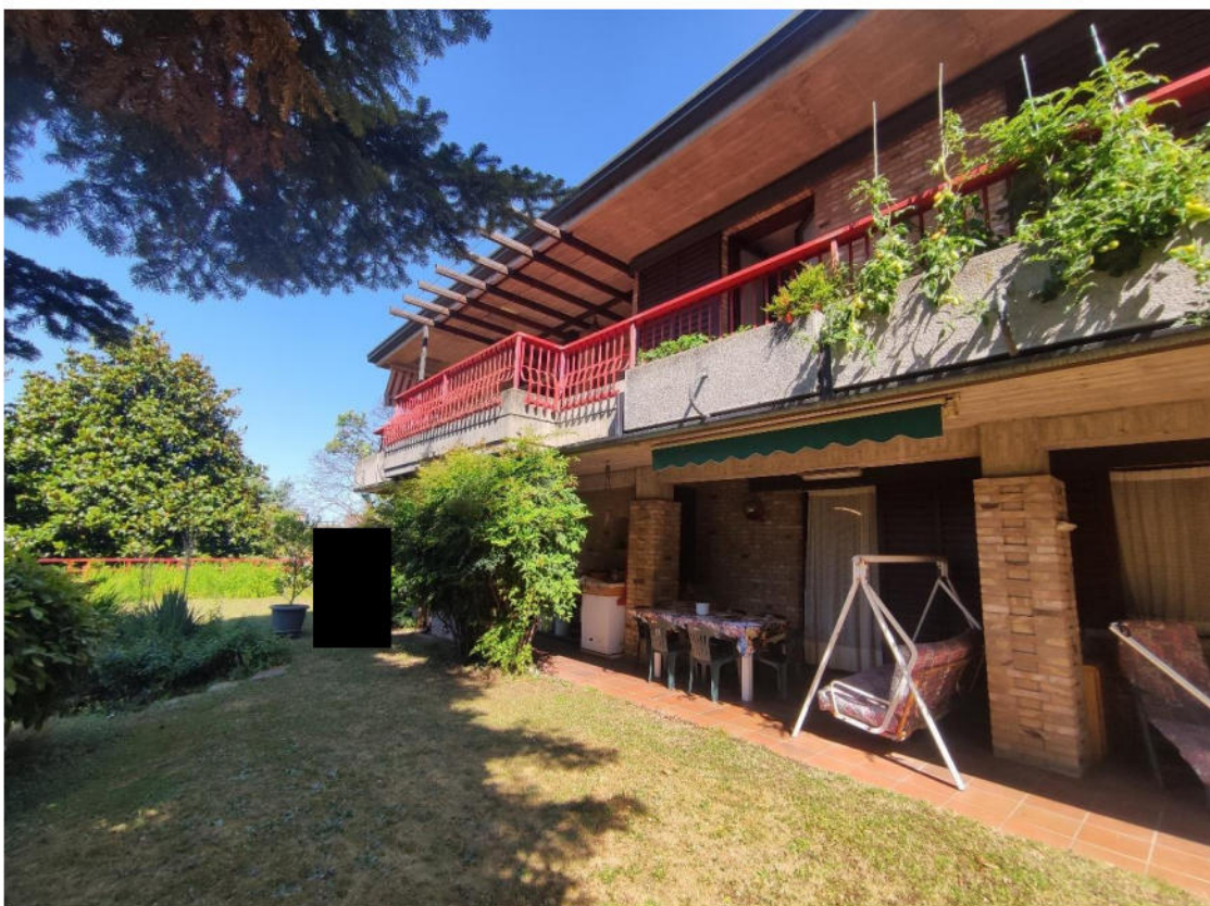
6. Vista facciata sud ed area di pertinenza appartamento al piano terra
