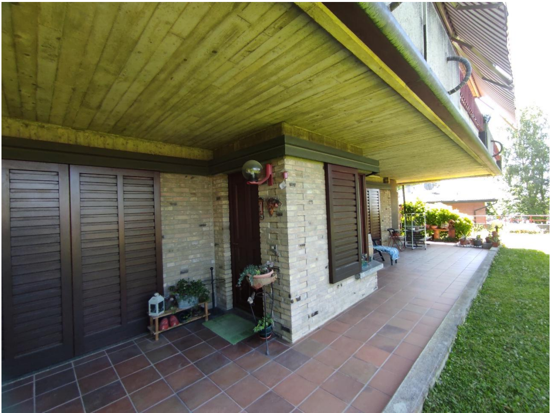
7. Vista zona ingresso appartamento piano terra (part. 50 sub. 704)
