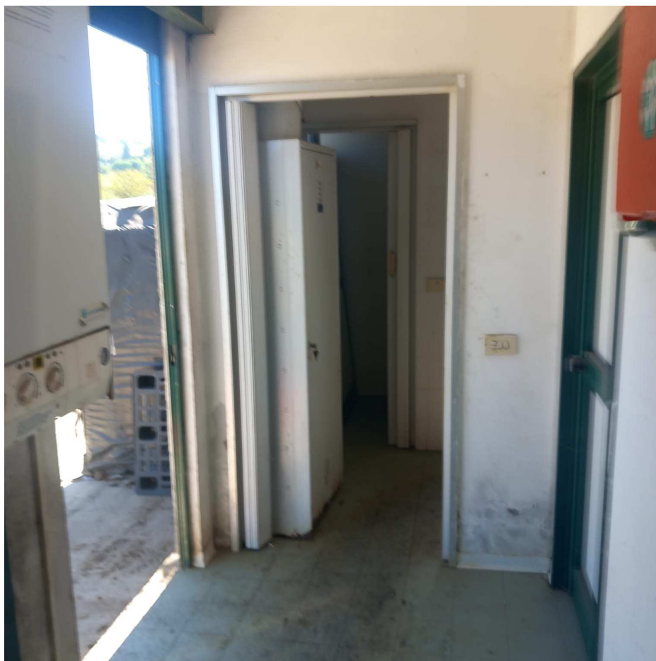
Foto 9 : parete corpo uffici e magazzino su 2 livelli Foto 10 uscita laterale pedonale e ingresso servizi igienici-
