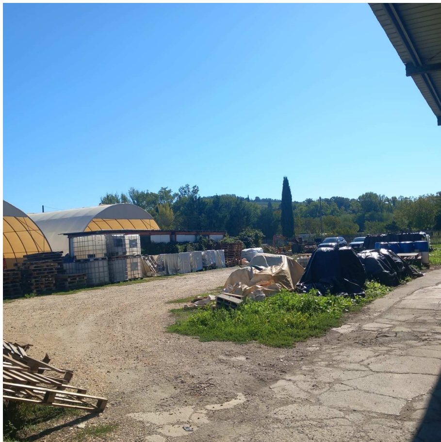
Foto 5 : facciata tergale ( zona carro ponte - Foto 6 : visione generale piazzale e zona manovra
