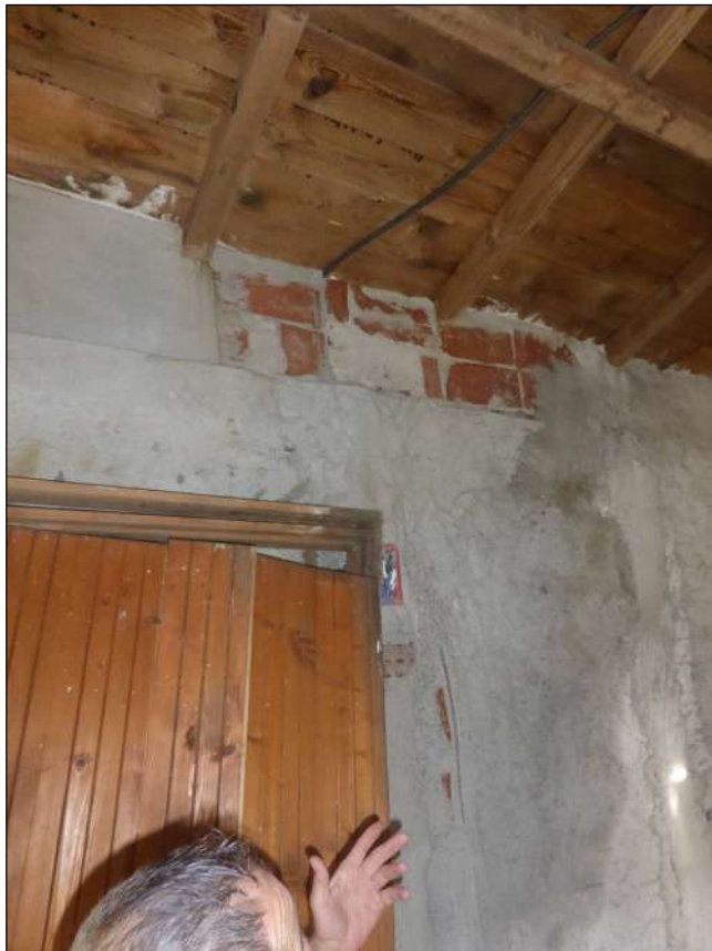
FOTOGRAFIA N. 49 Particolare della sopraelevazione
