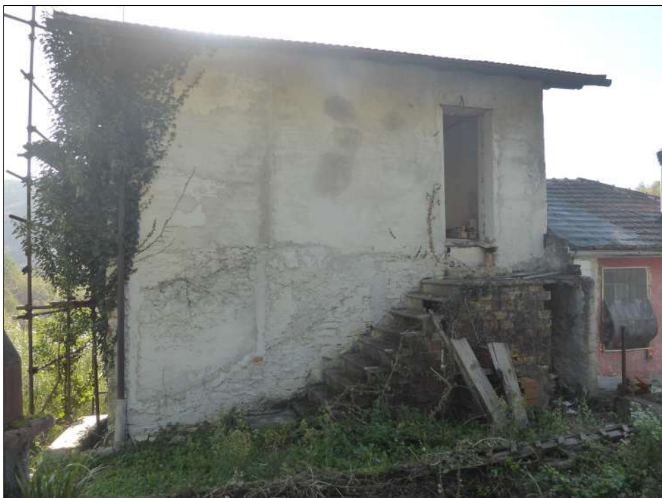
FOTOGRAFIA N. 15 Facciata nord-ovest con accesso al piano primo
