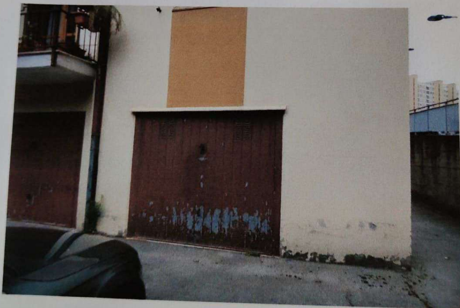
Foto 18. Potenza. Immobile in Via Tirreno. Ingresso garage piano terra
