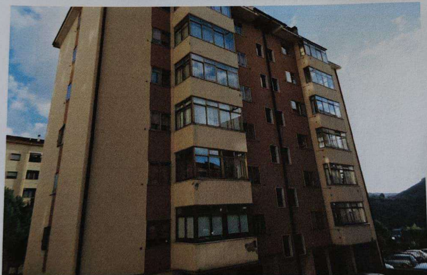
Foto 4. Potenza. Immobile in Via Tirreno. [REDACTED] Prospetto Laterale
