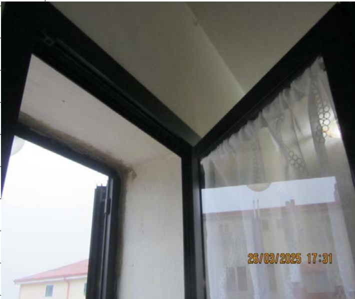
Foto n° 23: Vista particolareggiata della tipologia degli infissi esterni.
