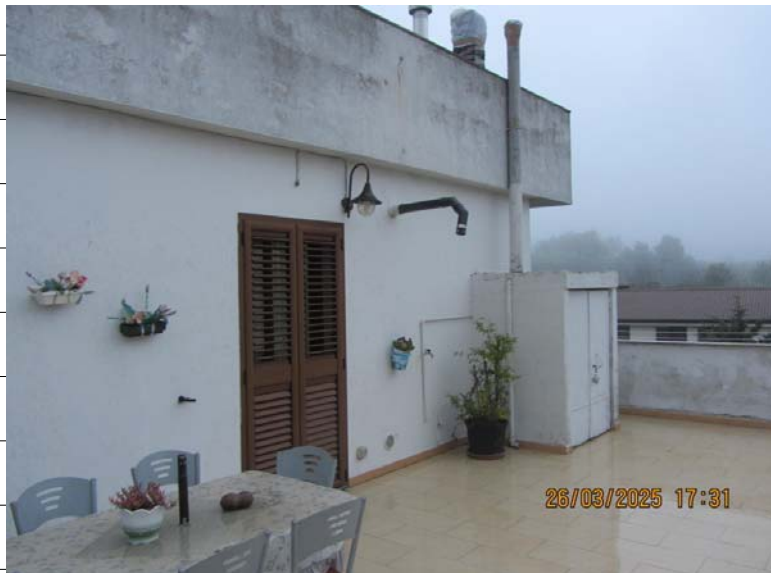
Foto n° 16: Vista prospettica dal terrazzo a livello ad uso esclusivo dell'infisso esterno porta finestra, con annessa persiana , di comunicazione del vano sala pranzo con il predetto terrazzo a livello.
