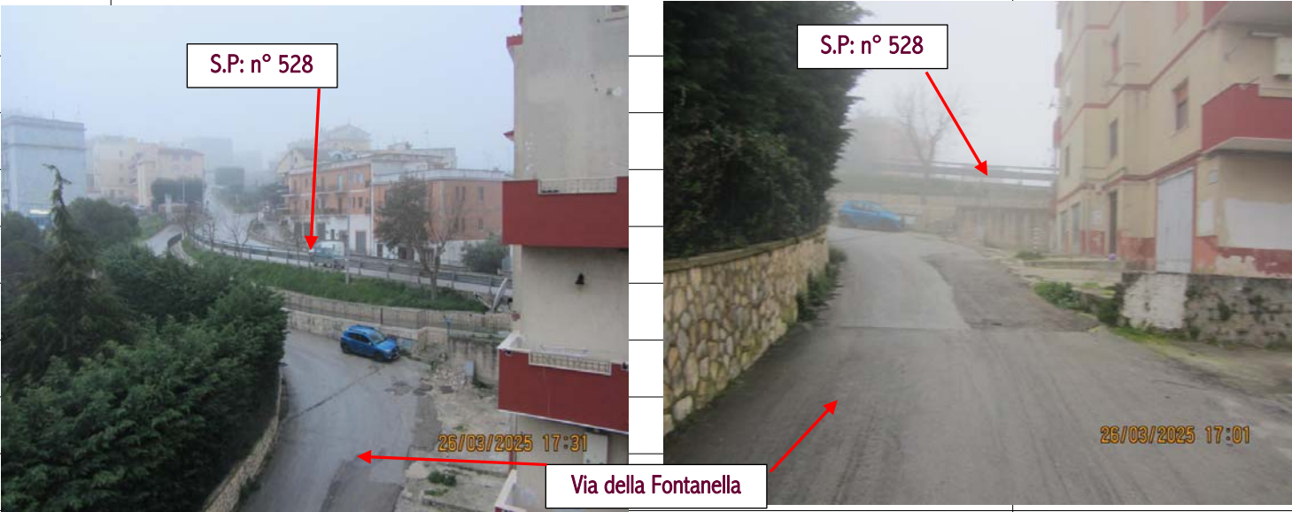
Foto n° 8: Vista prospettica aerea, nella foto di sinistra , e di piano, nella foto di destra , dell'arteria stradale comunale di via della Fontanella che proviene dalla S.P. n° 528, caratterizzata dal non essere di natura pianeggiante.
