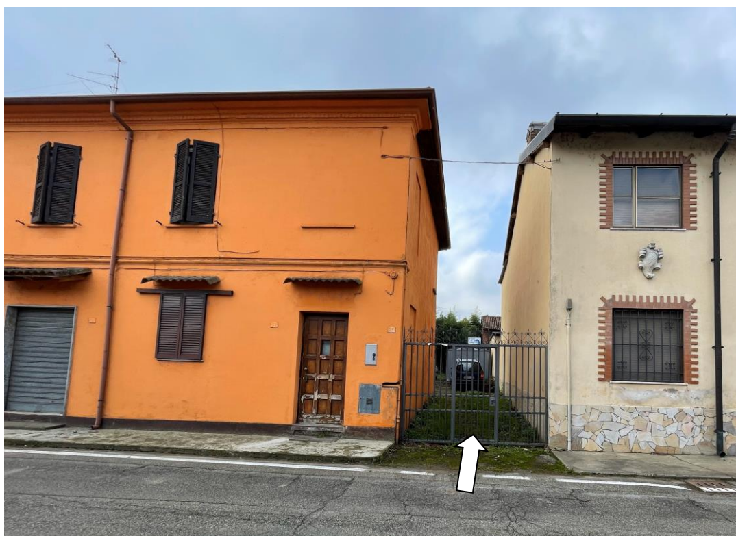
Accesso carraio civ. 23 su Via Maestra per accesso al bene 1.
