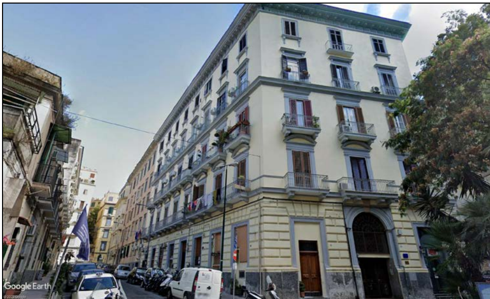
Il fabbricato di pz.tta Durante n. 2
