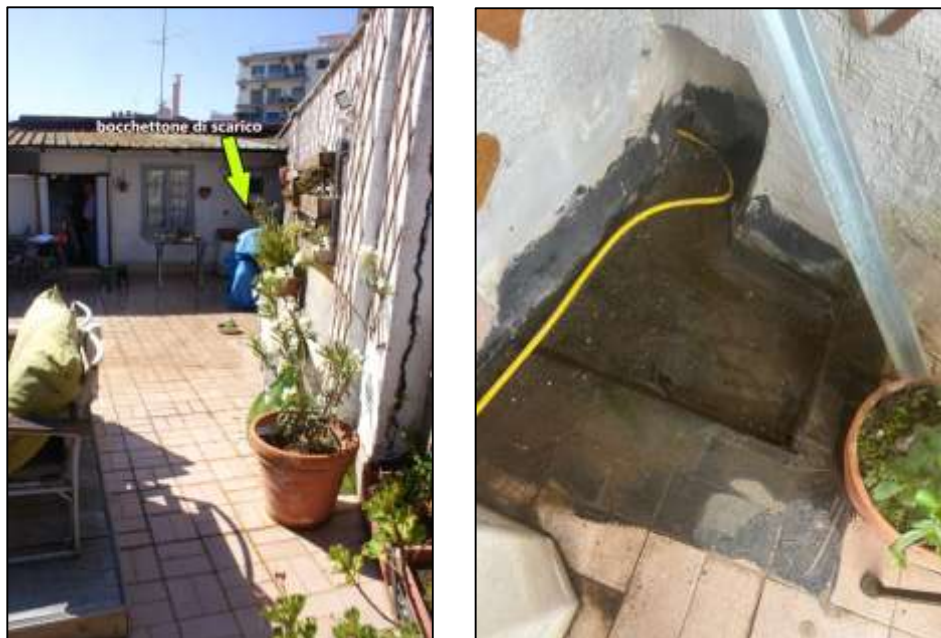
Terrazzo. Posizione dell'unico bocchettone di scarico e dettaglio del pozzetto.
