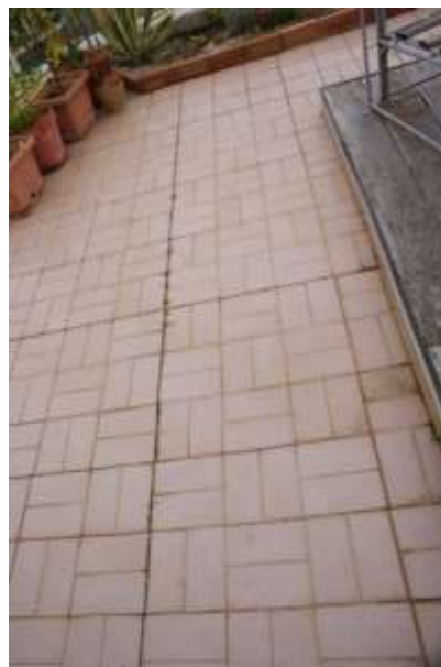
Terrazzo. Lungo le fughe delle mattonelle della pavimentazione si denotano marcati annerimenti e vegetazione.
