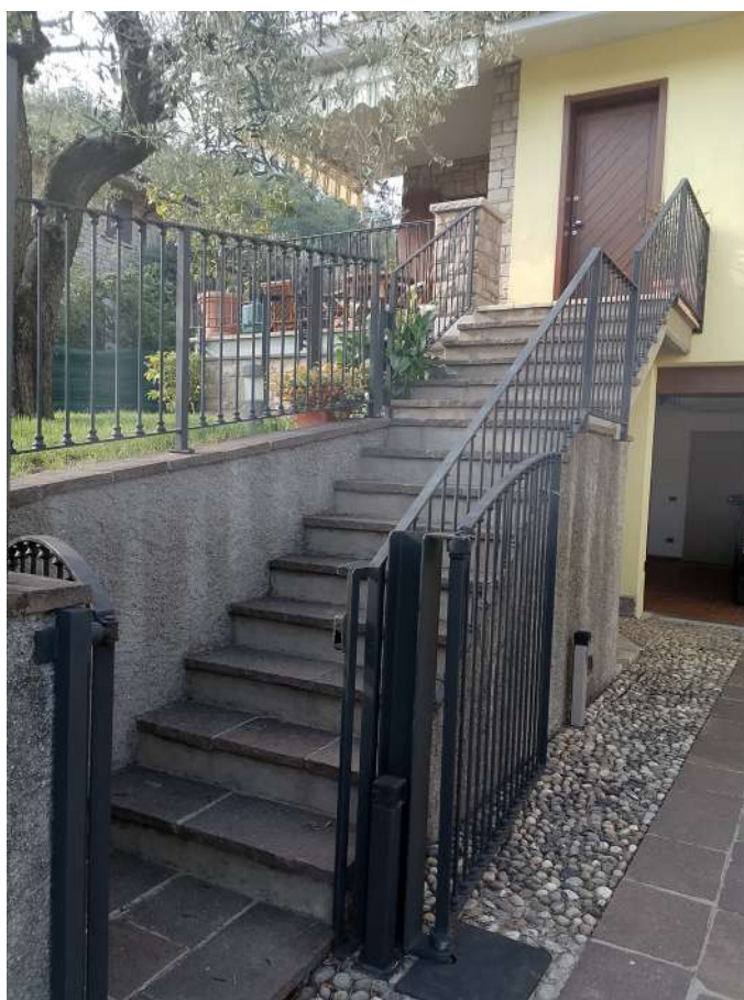
12. Scala esterna di accesso.
