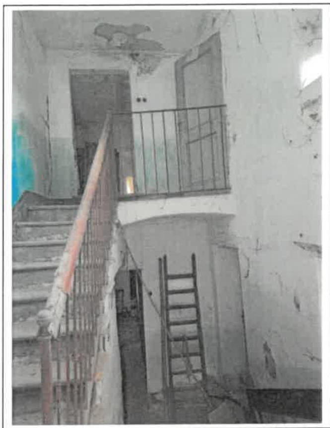
Foto n. 3 – Vista interna immobile in oggetto
