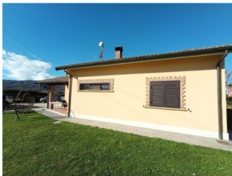
FOTO 7. Vista esterna (lato Nord-Est)
