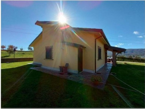
FOTO 5. Vista esterna dalla parte posteriore (lato Ovest)
