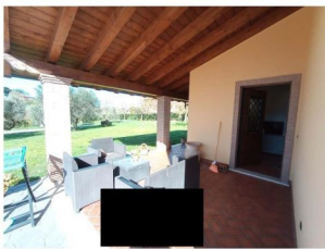
FOTO 8 - 9. Viste tettoia (lato Nord-Est)
