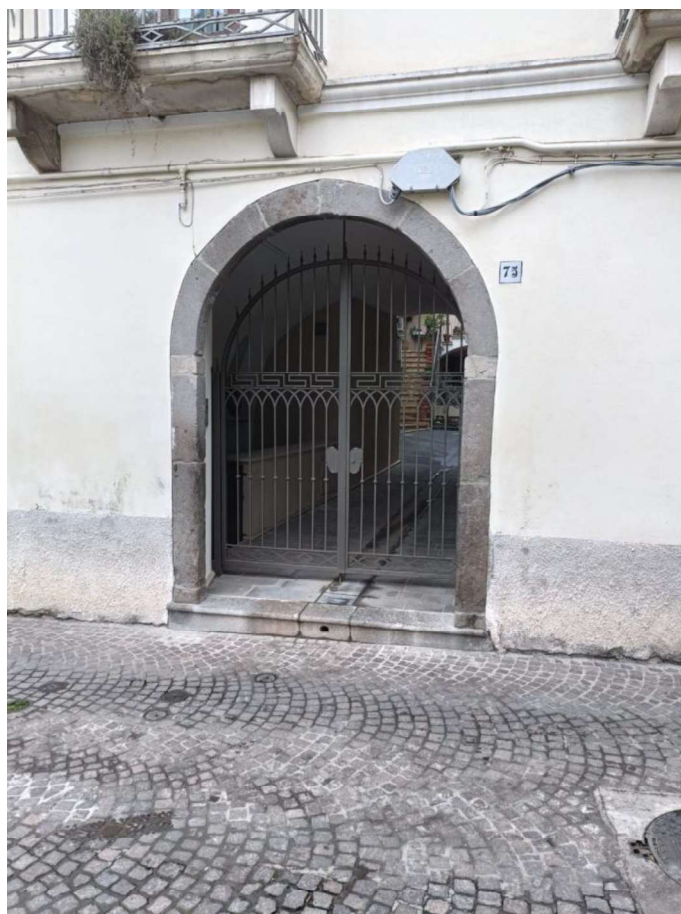
Figura 1 – Cancelli ingresso in Via Floriano Del Zio, n. 75.
