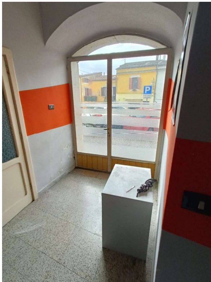
Figura 11 – Ingresso locale Via Floriano Del Zio, n. 73.
