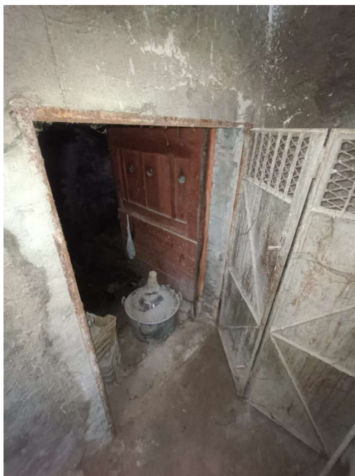
Figura 4 – Porta di accesso al Deposito.
