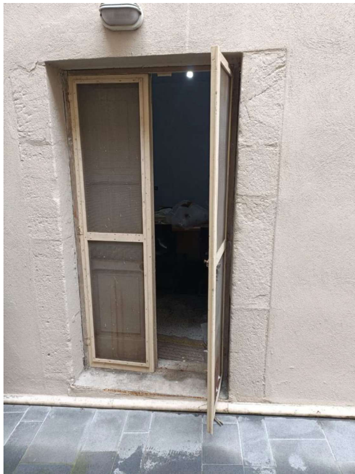
Figura 22 – Particolare porta accesso da corte esterna.
