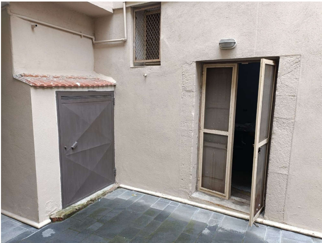
Figura 23 – Accesso ai locali da corte interna.
