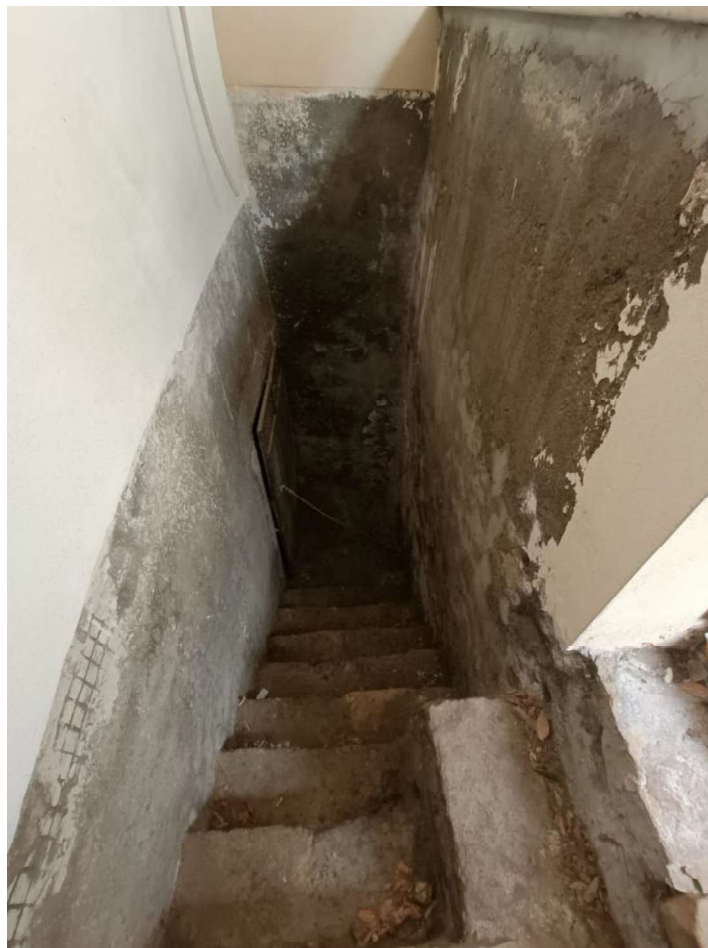
Figura 3 – Scalinata di accesso al Deposito interrato.
