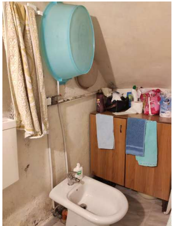
Sub. 5 – Bagno [Foto 4-5]
