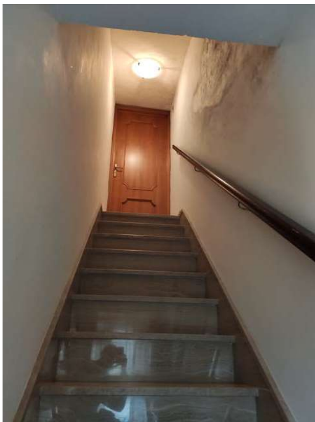
Sub. 4 - Vano scala verso piano 2° [Foto 17]
