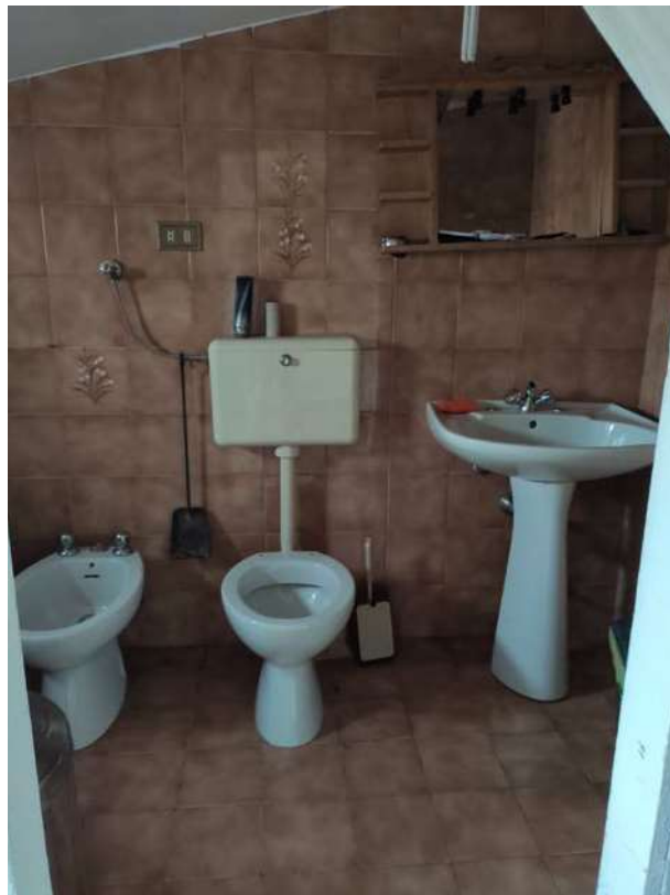
Sub. 4 – Secondo piano – servizio igienico [Foto 24-25]
