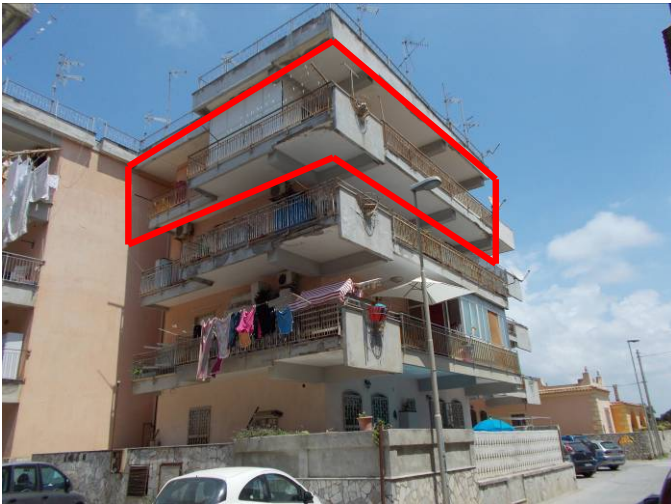
Il fabbricato visto dalla via Licola
