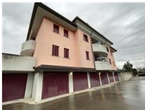
Vista prospetto sul retro.
