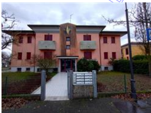
Vista prospetto principale.
