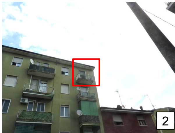
Dettaglio facciata sud alloggio
