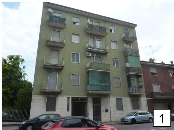
Facciata sud condominio
