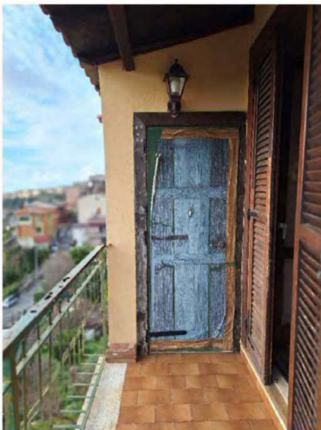
FOTO N. 10: Particolare balconcino lato Sud-Ovest
