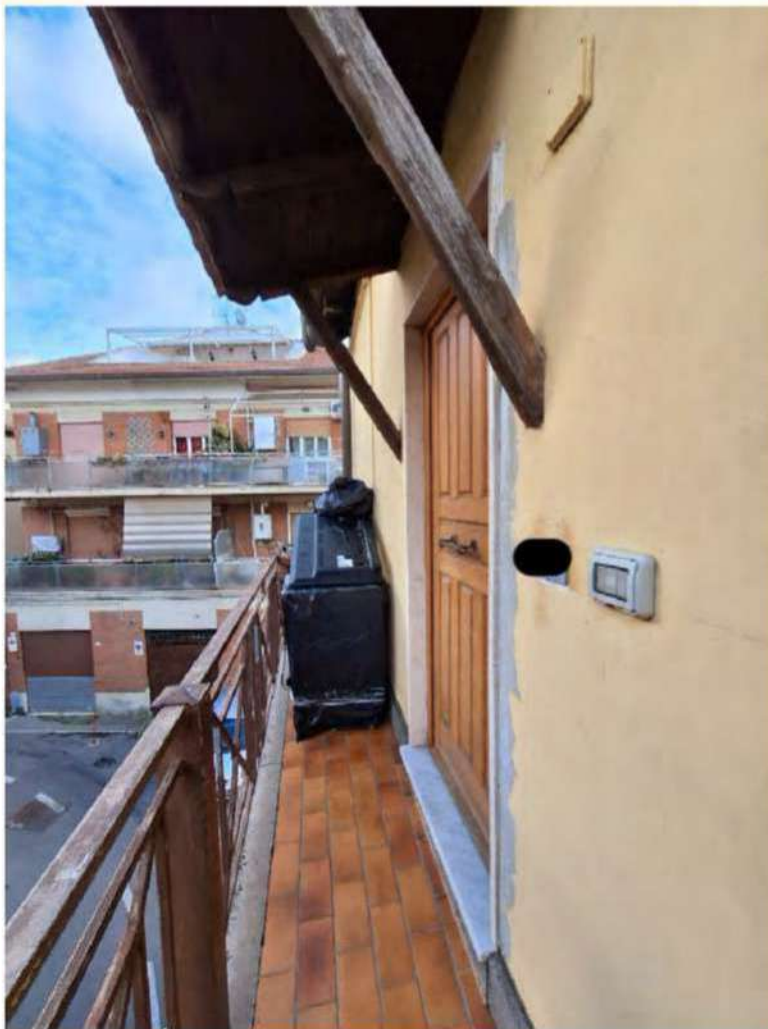
FOTO N. 5: Particolare portoncino ingresso immobile e ballatoio comune
