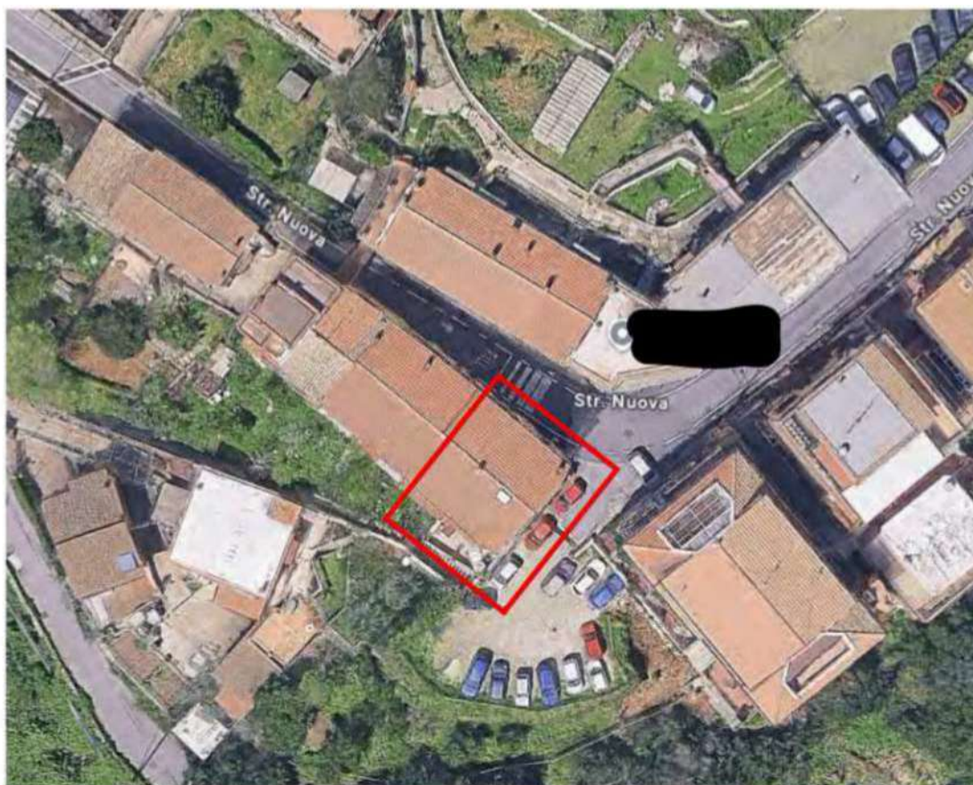
Particolare vista dall'alto fabbricato
