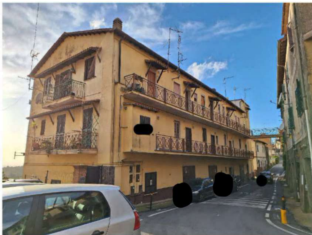
FOTO N. 3: Particolare lato sud-est e nord-est (lato ingresso)
