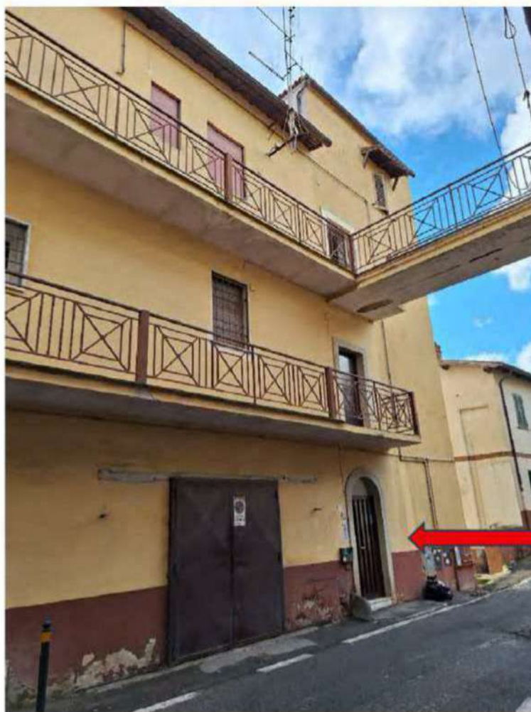
FOTO N. 4: Particolare ingresso condominio
