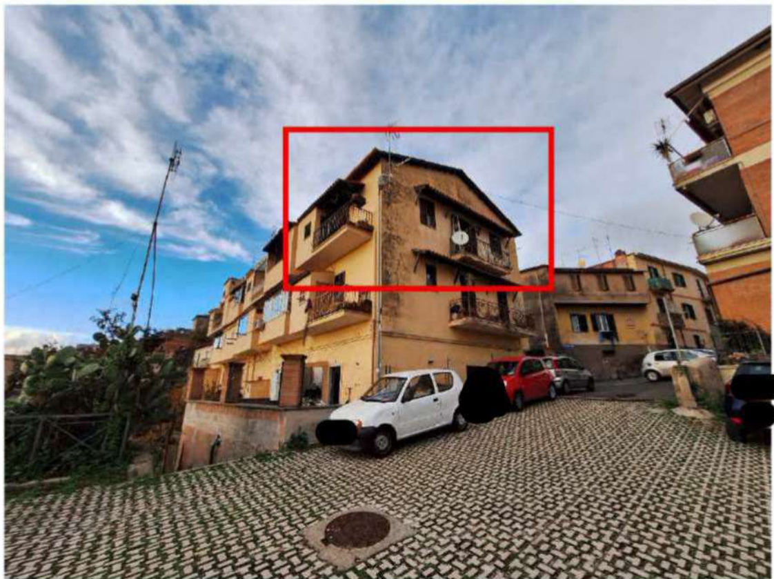
FOTO N. 1: Particolare facciata lato sud-est e sud-ovest
