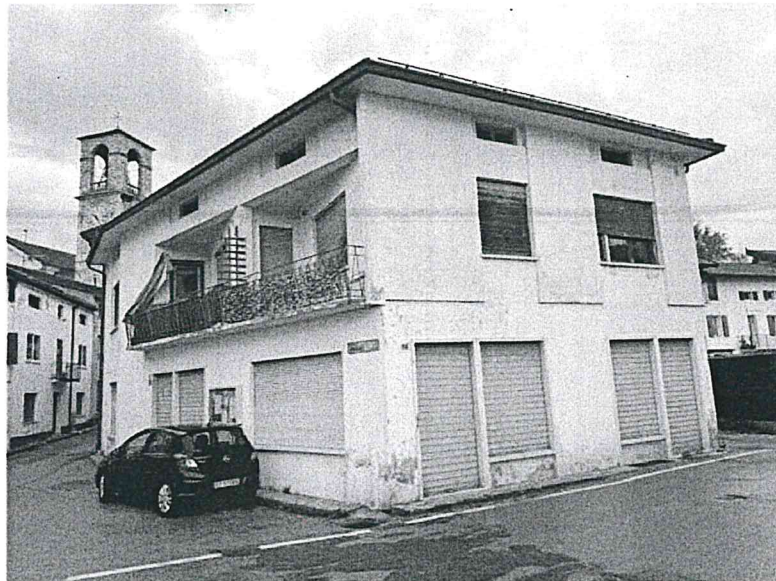
Foto panoramica fronte Sud-Ovest
