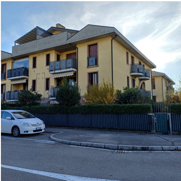
Vista esterna dell'abitazione (lato est verso i parcheggi)
