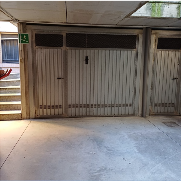
Vista esterna del box
