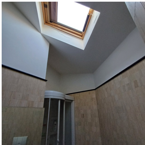
Vista lucernario del bagno al piano terzo
