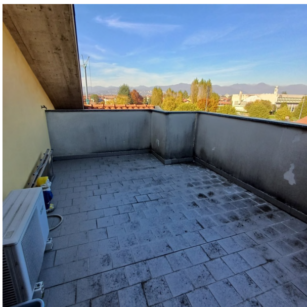
Vista terrazzo al piano terzo
