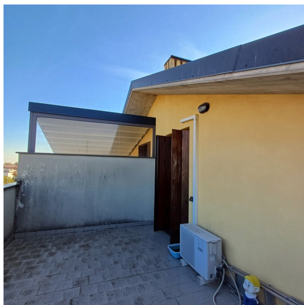
Vista terrazzo al piano terzo
