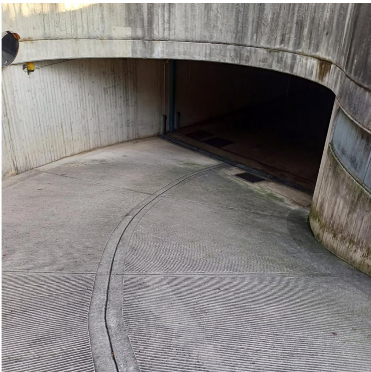
Vista corsello di accesso al piano interrato con i box
