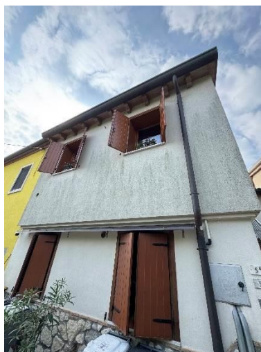
Foto n. 15 – Immobile prospetto Nord
