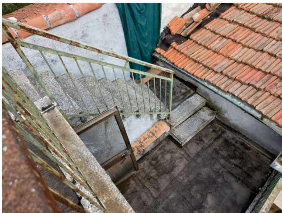
Foto 15 – Vista scala di collegamento tra piano primo e terrazzo piano secondo
