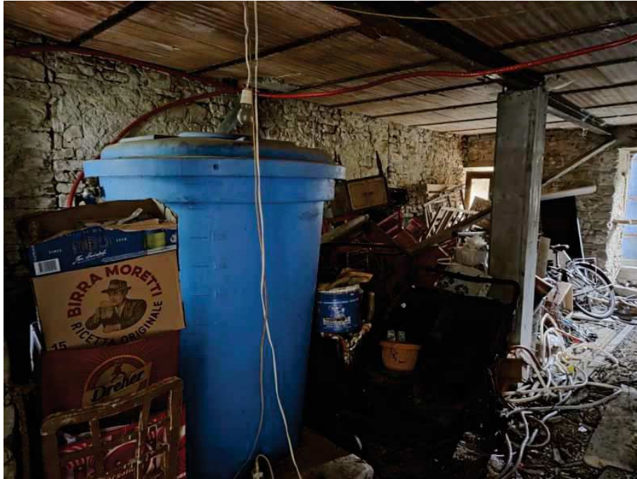
Foto 23 – Vista locale di deposito piano terra
