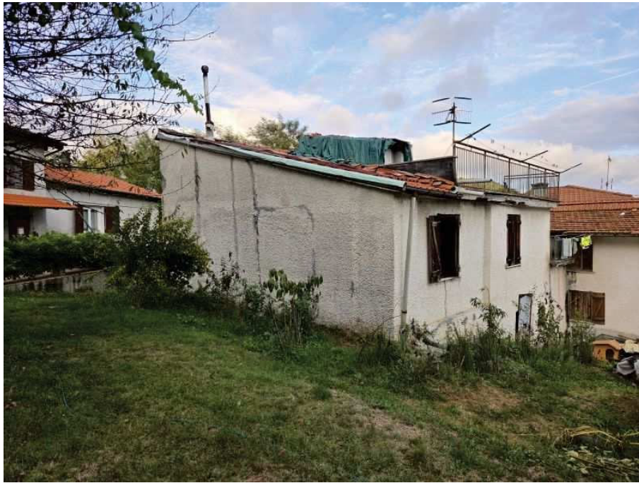
Foto 5 – Vista prospetto lato ovest e sud
