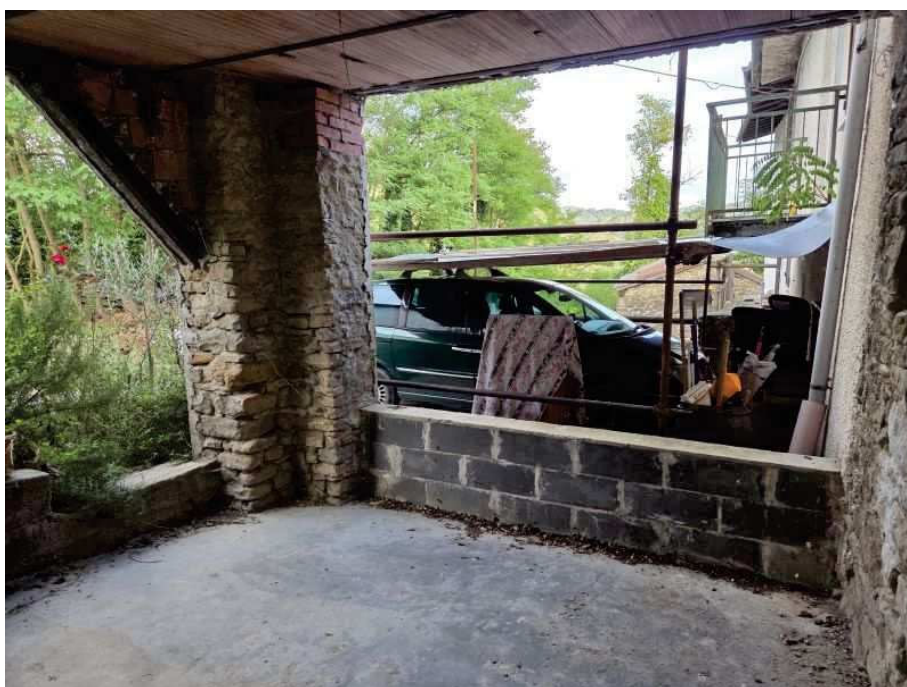
Foto 22 – Vista portico piano terra
