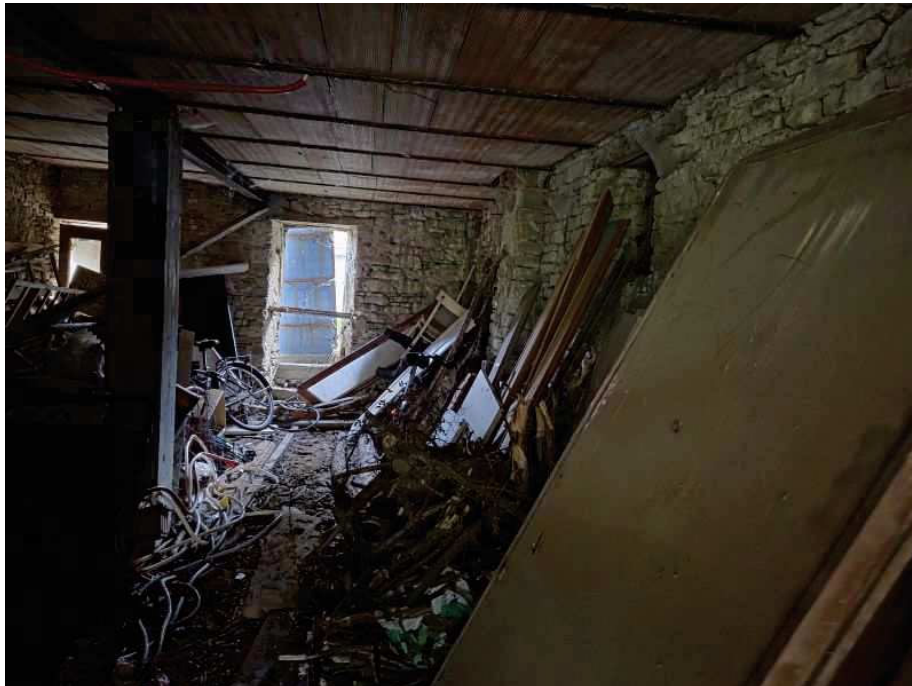
Foto 24 – Vista locale di deposito piano terra
