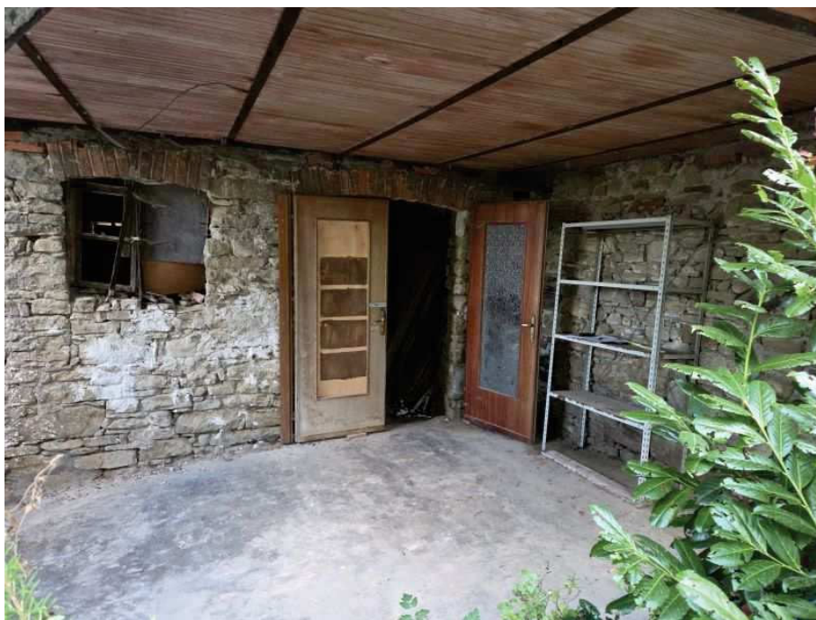
Foto 21 – Vista portico piano terra
