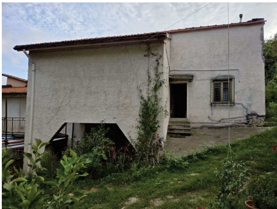
Foto 3 – Vista prospetto ingresso, lato nord
