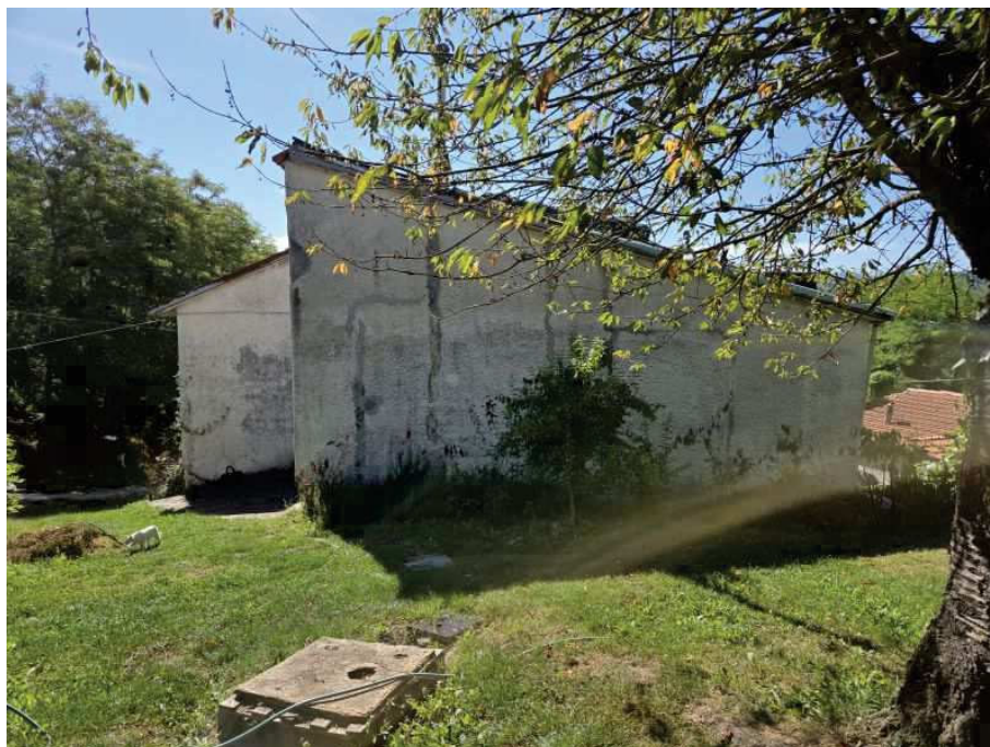
Foto 4 – Vista prospetto lato ovest
