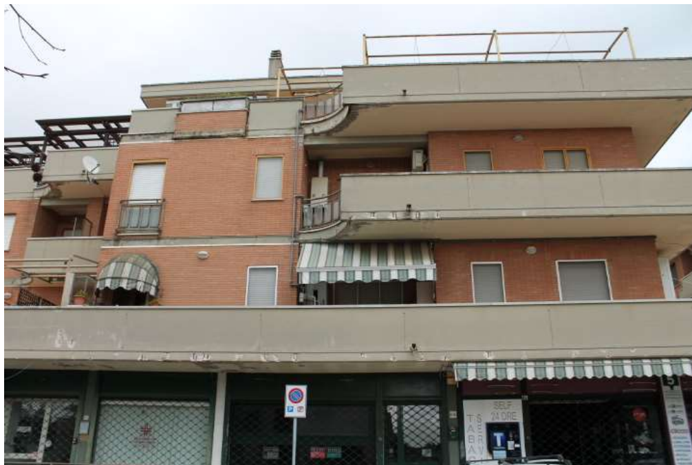
Vista lato fronte strada
