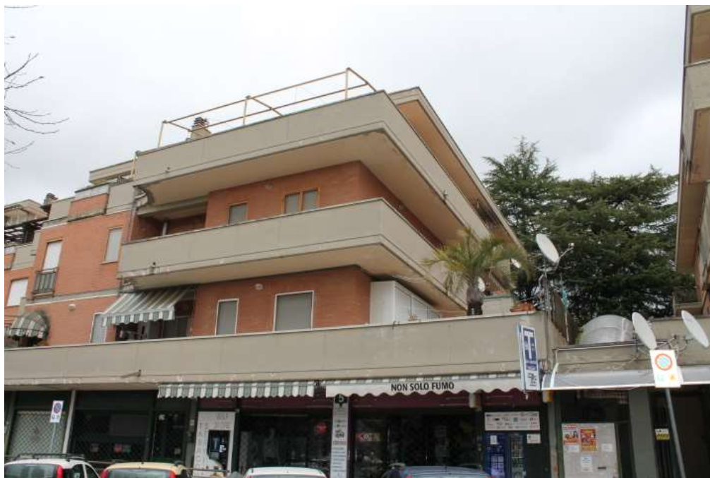
Vista lato abitazione
