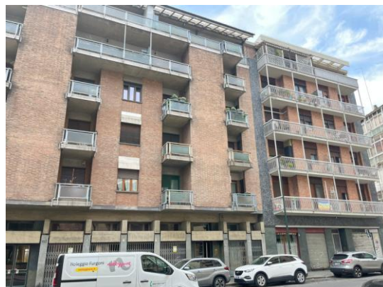
VISTA ESTERNA STABILE
