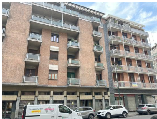
VISTA ESTERNA STABILE
