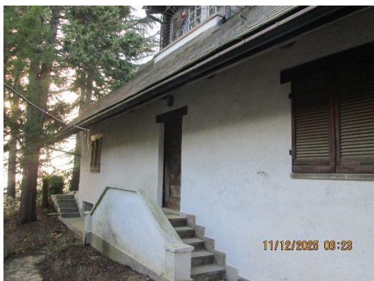
Facciata nord-est, accesso al p. rialzato
