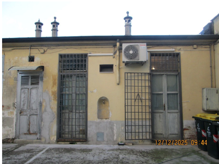
Facciata su cortile del basso fabbricato
