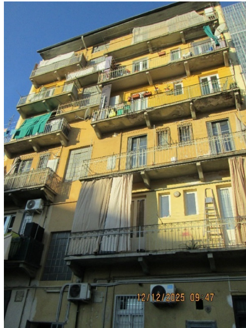
Facciata su cortile
