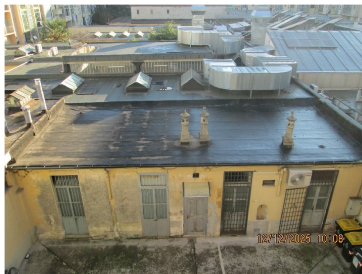
Veduta dall'alto del basso fabbricato
