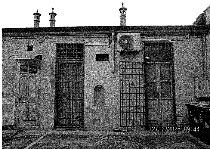
Facciata su cortile del basso fabbricato
