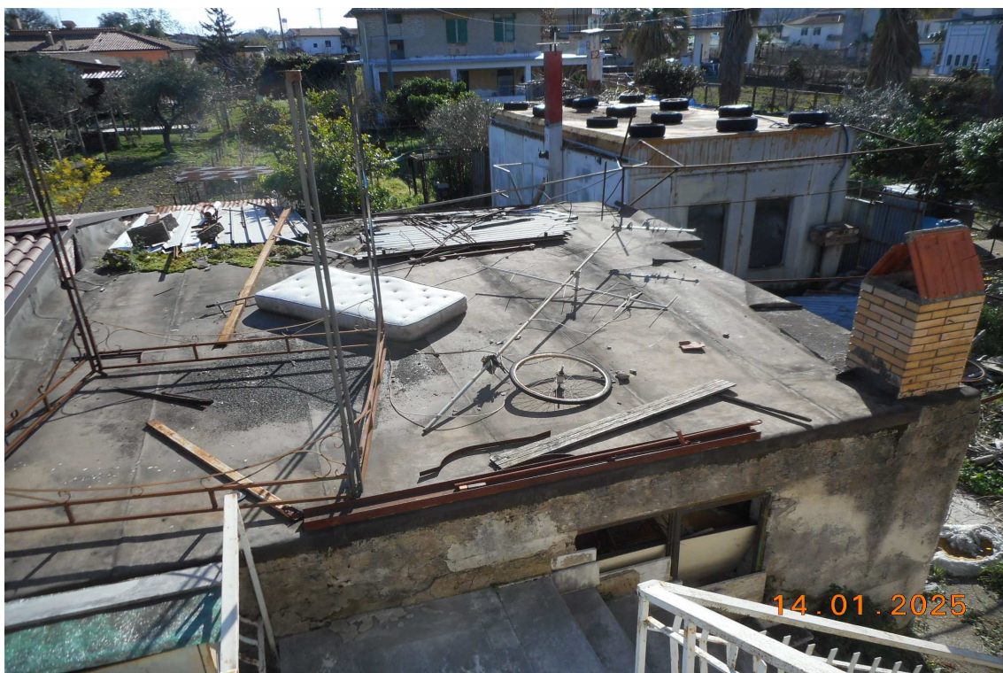
FOTO 04 – Vista della copertura del bene 2
