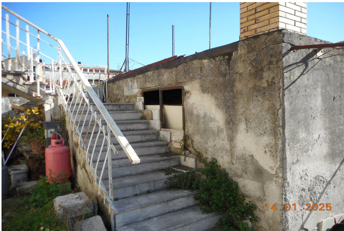
FOTO 01 – Vista del fronte nord del bene 2 e della scala d'accesso al bene 1
