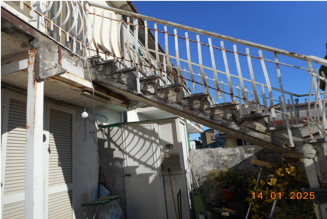
FOTO 17 – Vista della scala d’accesso al bene 1
