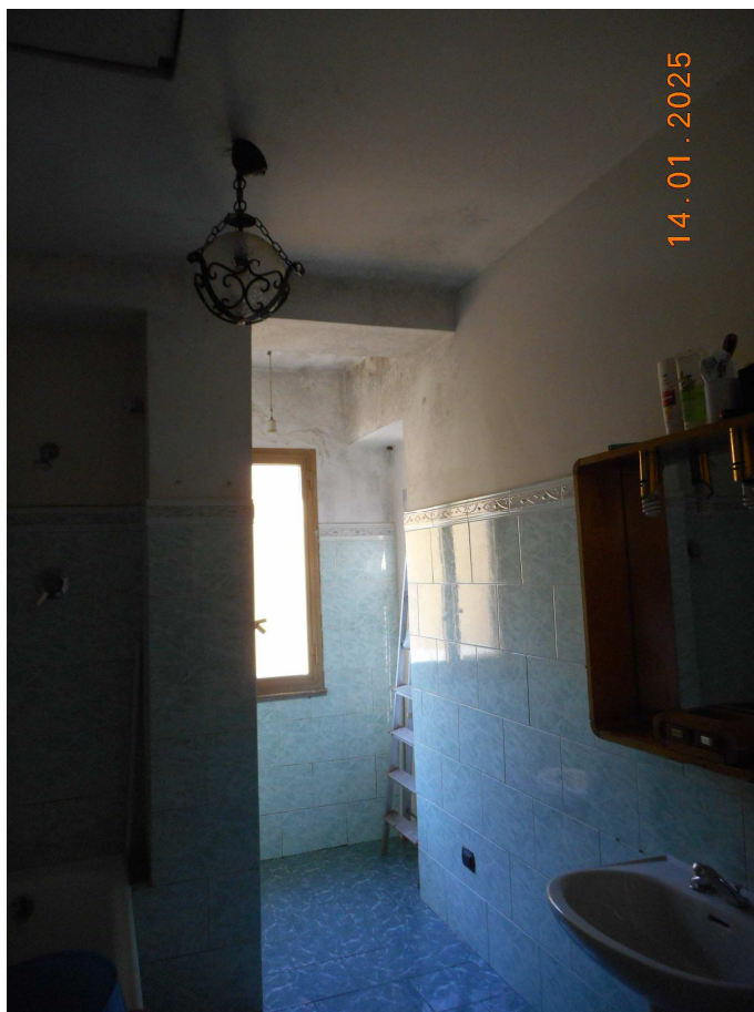
FOTO 12 – Vista del bagno del bene 1
