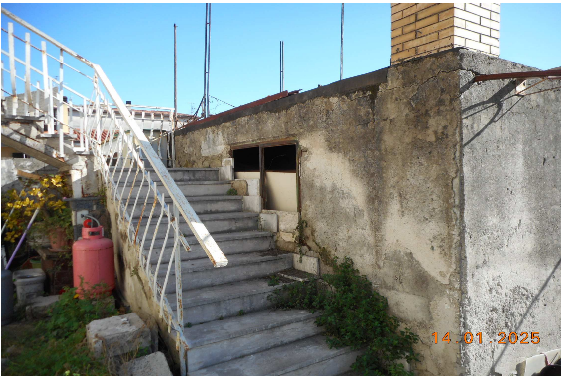
FOTO 18 – Vista della scala d’accesso al bene 1 e fronte nord del bene 2
